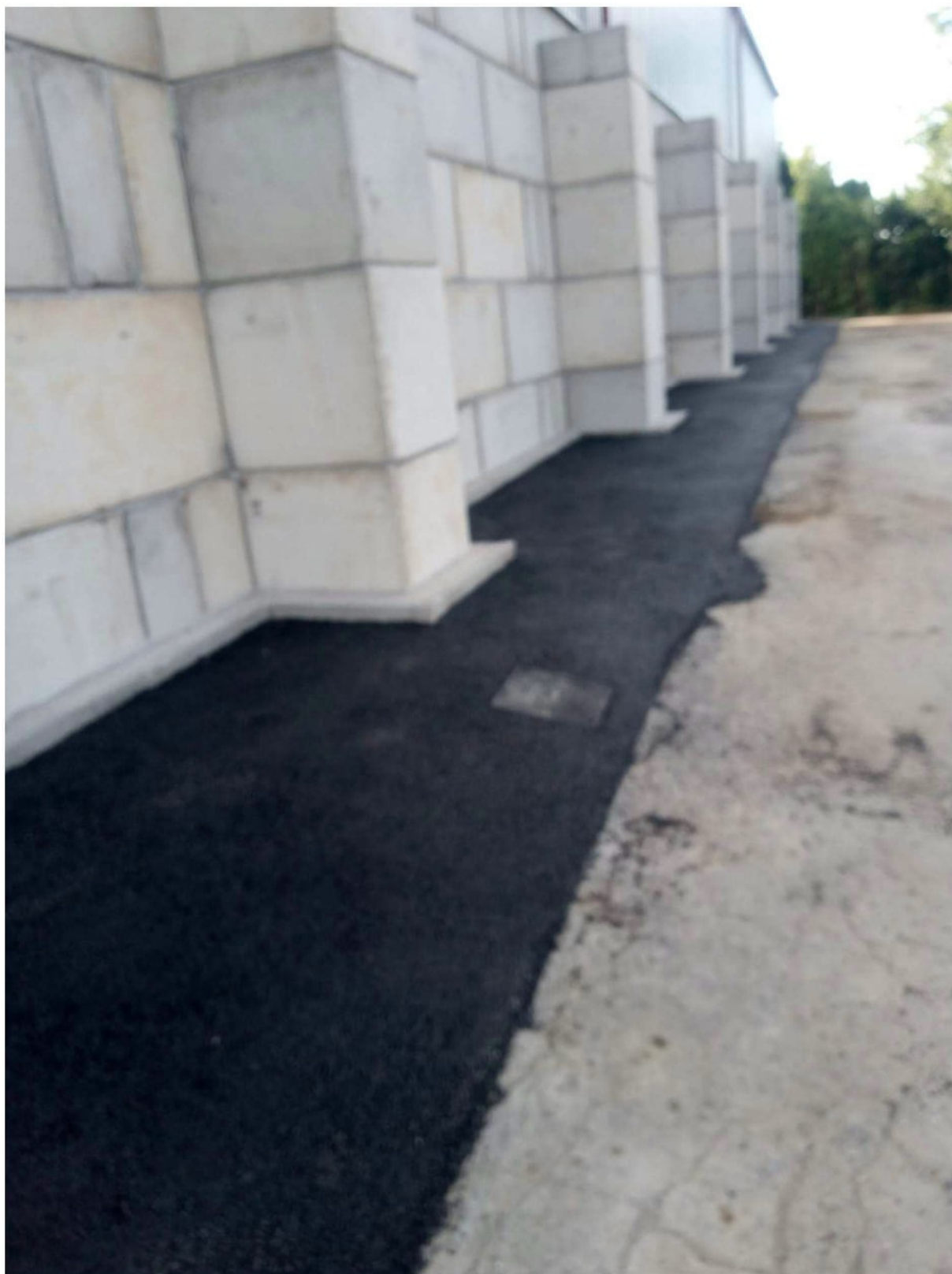
Obrázek 2. Ochrana hydroizolace obruba, tmelení
