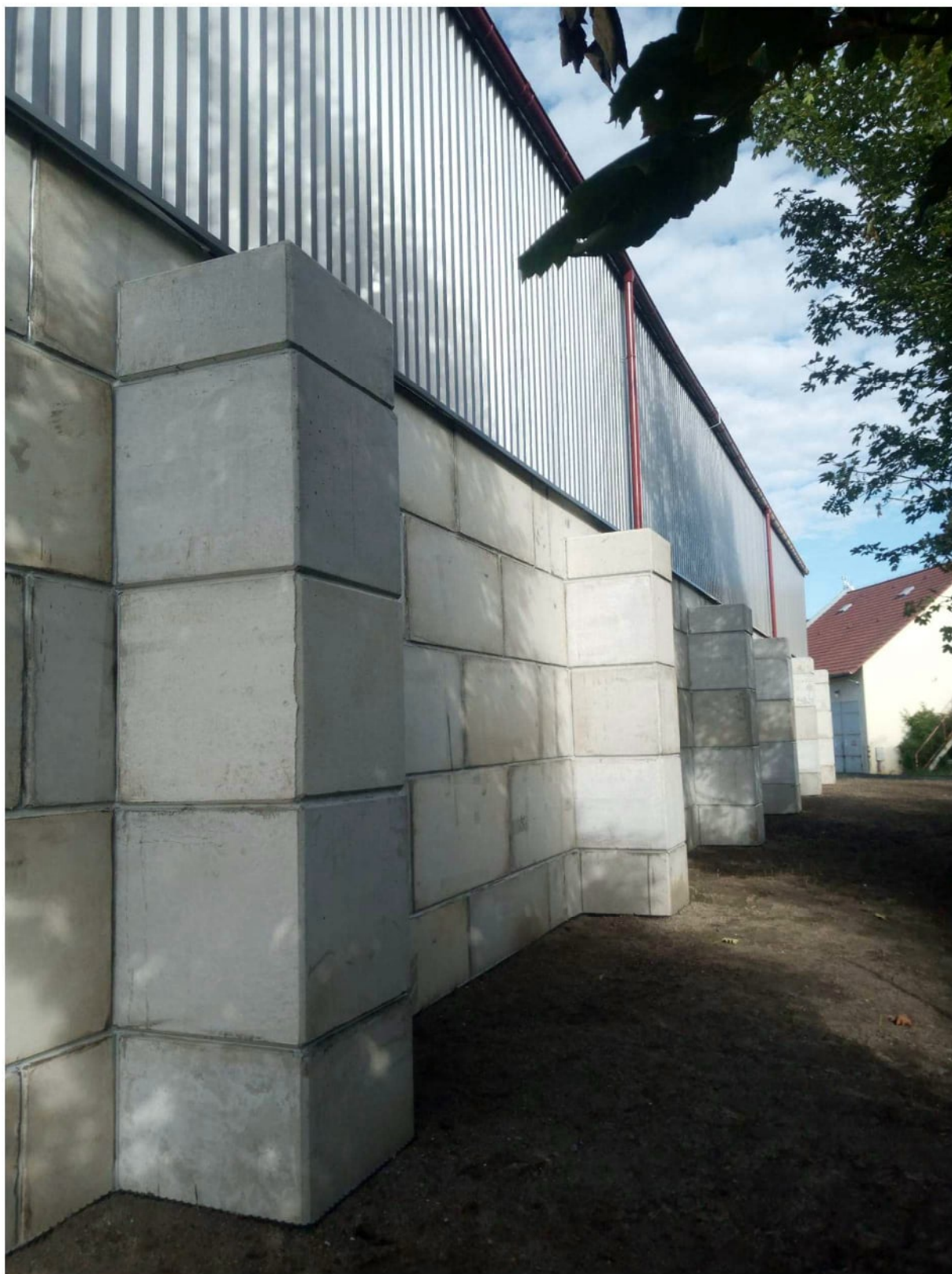
Obrázek 3. Přejchod beton / ocelovka, ochrana hydroizolace nopovka, tmelení
