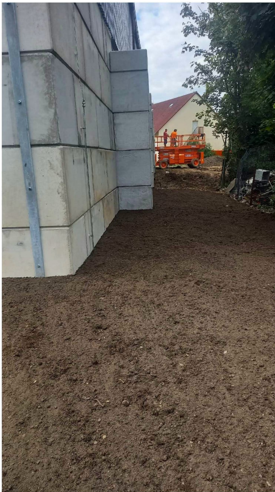
Obrázek 1. ochrana hydroizolace nopovka, tmelení
