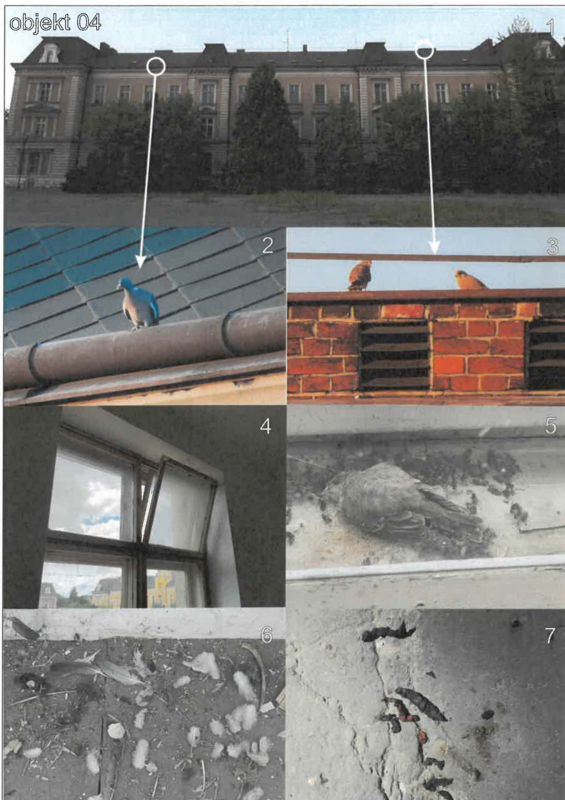
Obr. č. 4 – pohled na objekt 04 z areálu, poz. 1 – pohled na budovu; poz. 2 – holub hřívnač, jeden z hnízdičů na budově; poz. 3 – poštolky obecné, hnízdi na budově č. 7, ale využívají okolní budovy; poz. 4 – otevřená okna slouží k větrání, ale zároveň představují past na netopýry a ptáky v případě, když dojde k uzavření; poz. 5 – mumie lejska šedého nalezena v jednom z meziokní; poz. 6 – peří holubů; poz. 7 – trus kun.
