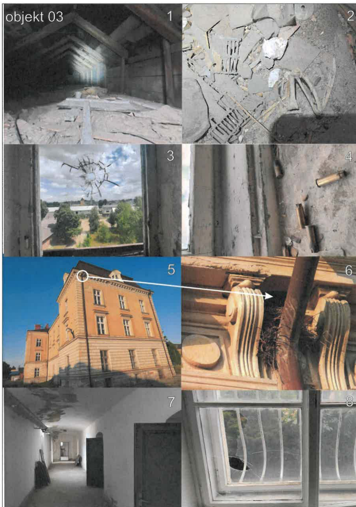
Obr. č. 3b – pohled na objekt 03, poz. 1 – půdní prostory se zbytkami holubů a ojedinělým trusem netopýrů či trusem kun; poz. 2 – zbytky holuba s trusem netopýrů; poz. 3 – v rámci budovy probíhají policejní cvičení, některé okna jsou rozstřílena, poničena, umožňující vnikání živočichů do budovy; poz. 4 – jedny z mnoha cvičných nábojnic; poz. 5, 6 – za okapy jsou často hnízda holubů, nebo vstupy do půdních prostor; poz. 7 – sklepní prostory; poz. 8 – jedno z mnoha poškozených oken.
