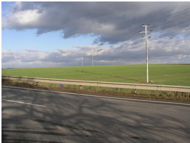
Celkový pohled od dálničního sjezdu
