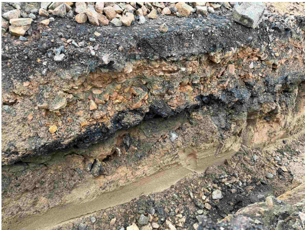
SO 106 km 4,360 - vrstvy s obsahem dehtu, patrná černá hmota v podloží.
