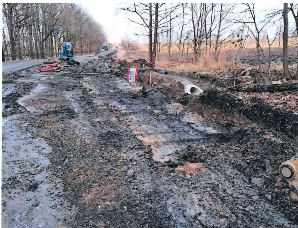
Foto č.1 – stávající podloží násypu v km 2,060 – 2,160
