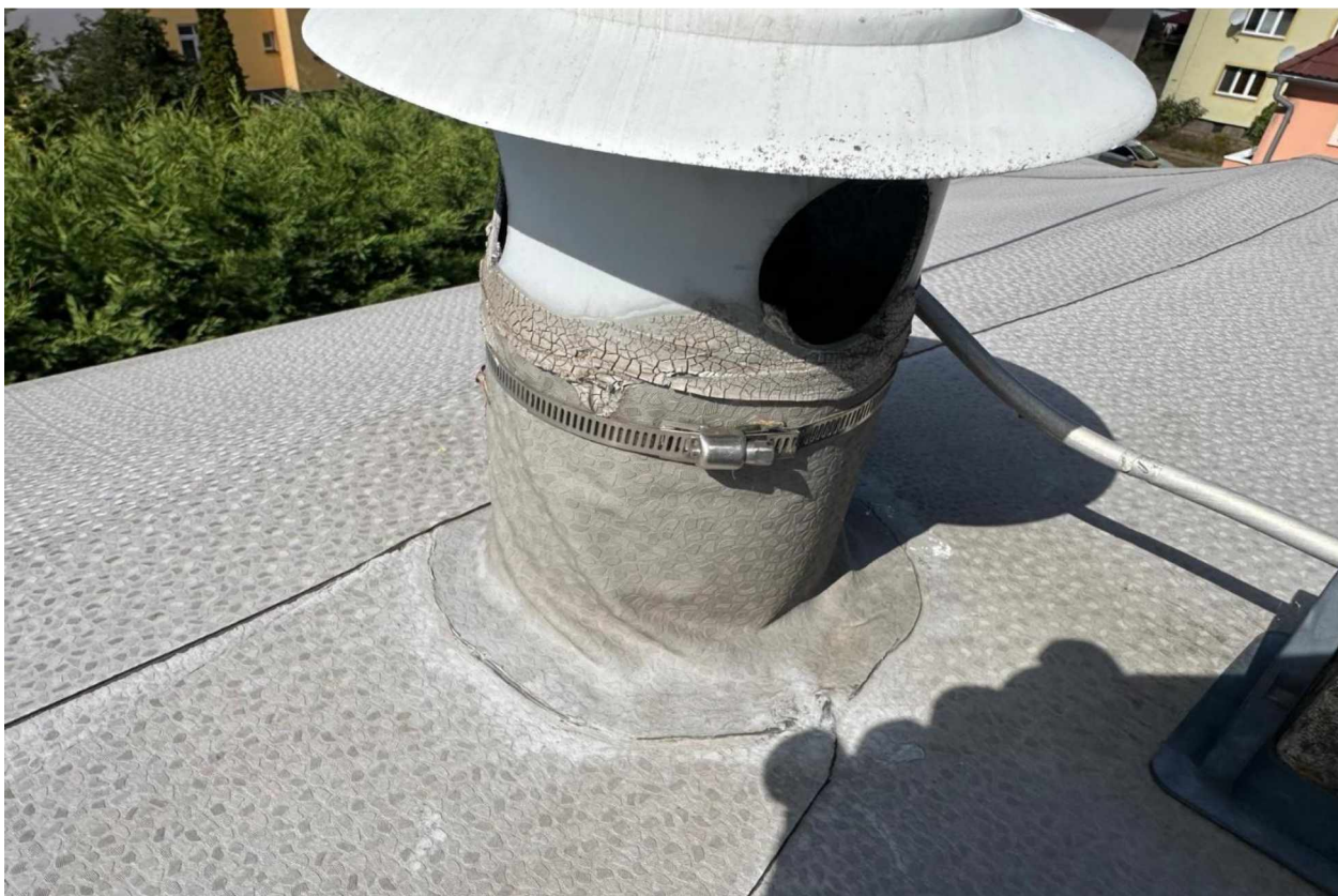
Foto/5/ ukázka degradované fólie na detailu komínku
