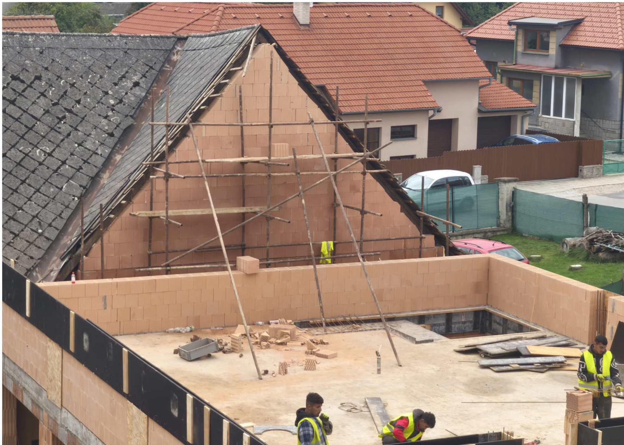
Sousední objekt - Nová štítová stěna
