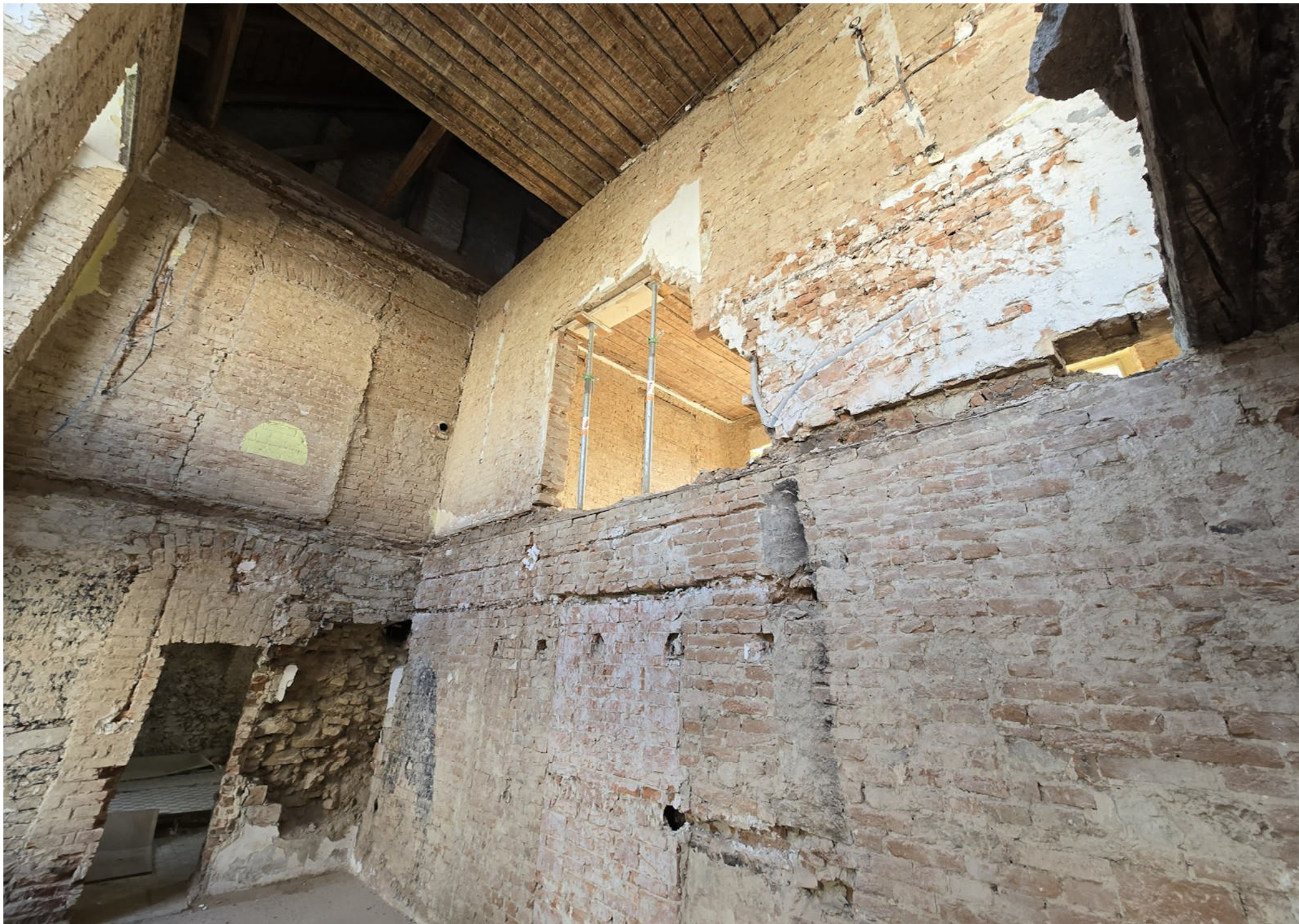
SO 01 - Bouraná stěna
