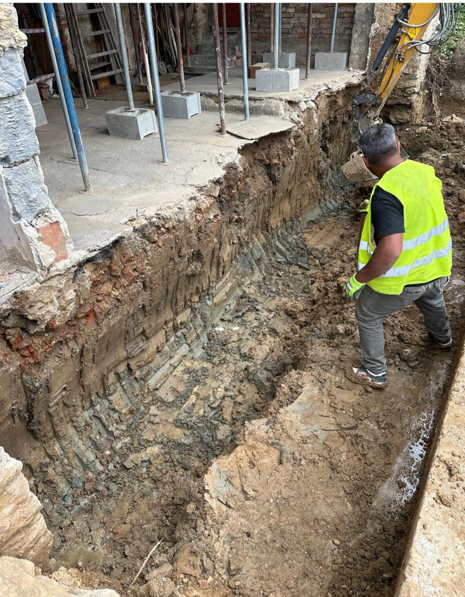
Sousední objekt - Výkop základů
