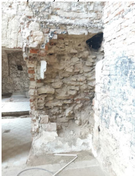
Obrázek: stav zdiva po odkrytí.
