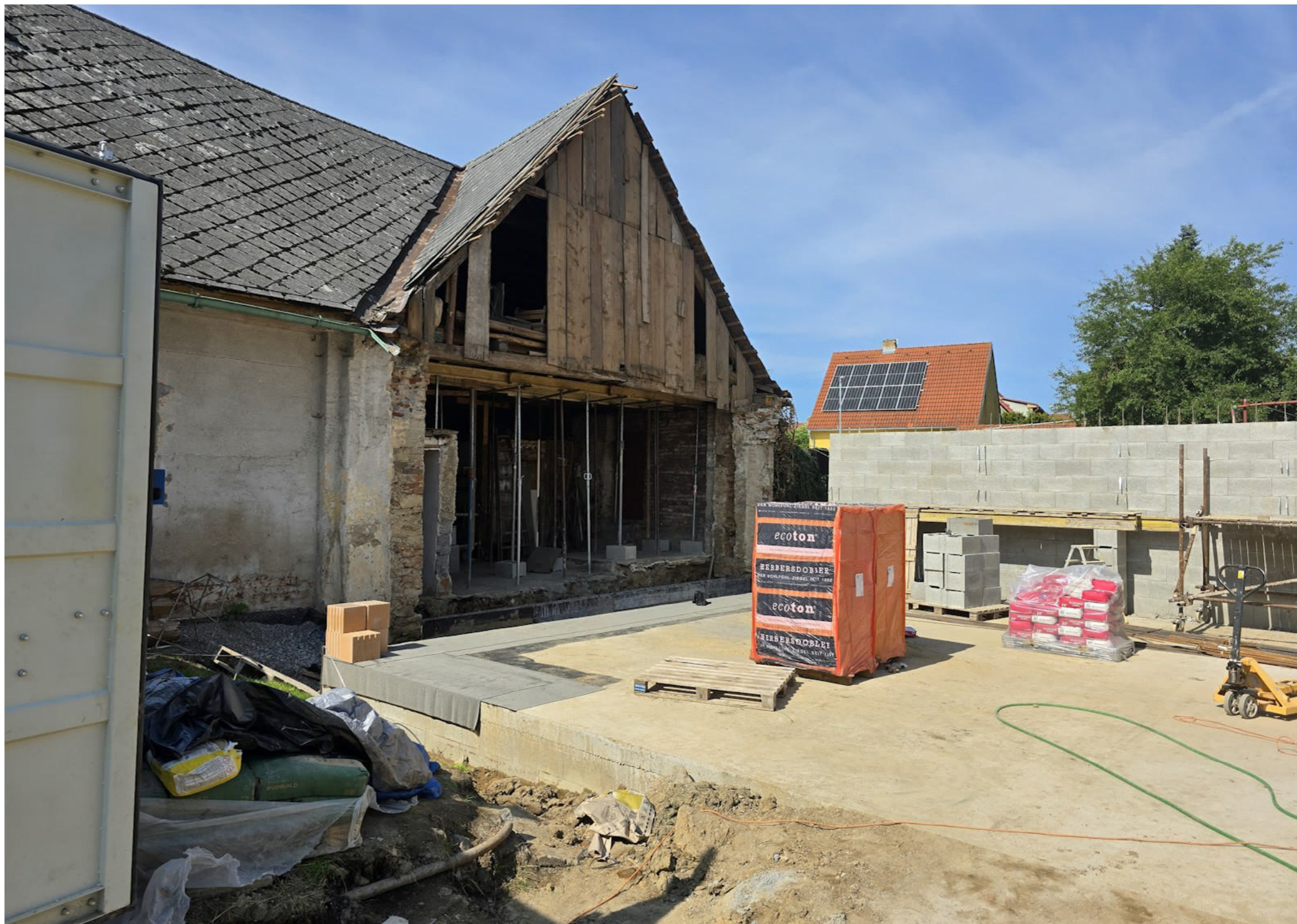
Sousední objekt - Statické zajištění, demolice, nový základ
