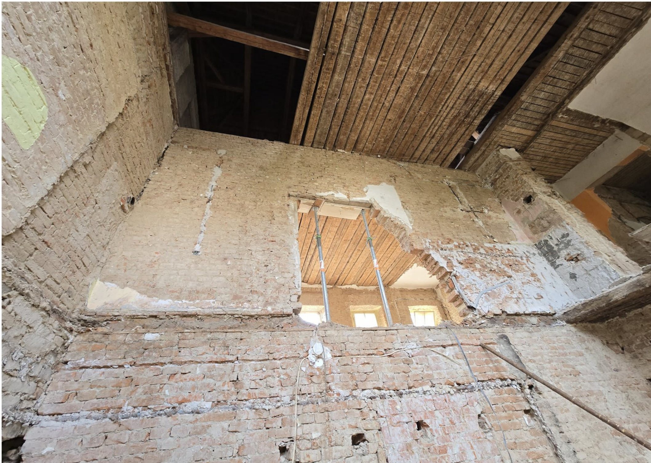
SO 01 - Bouraná stěna
