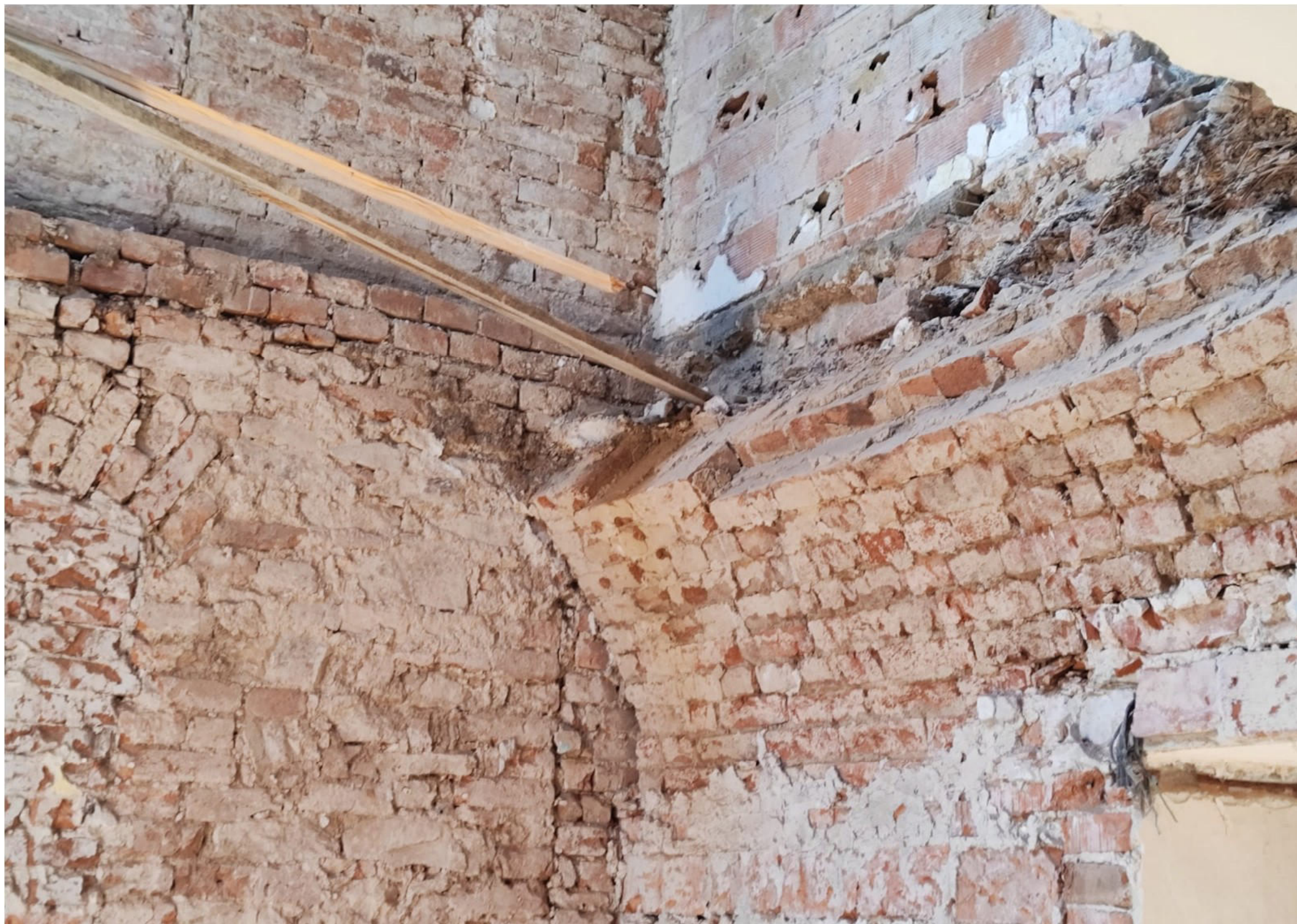
SO 01 - Demolice klenby
