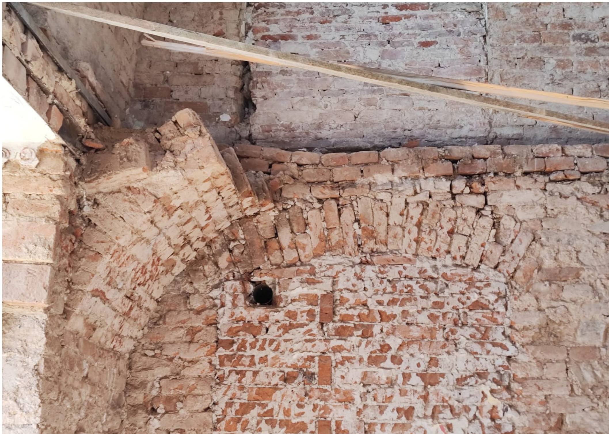
SO 01 - Demolice klenby
