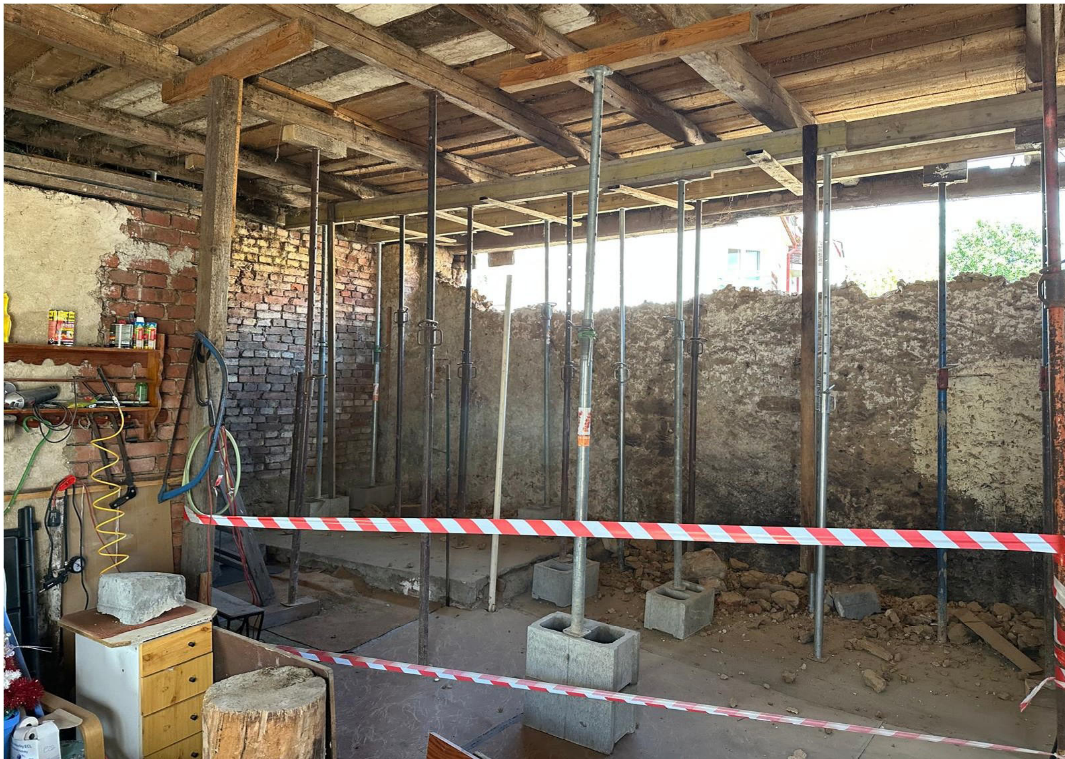
Sousední objekt - Statické zajištění a demolice
