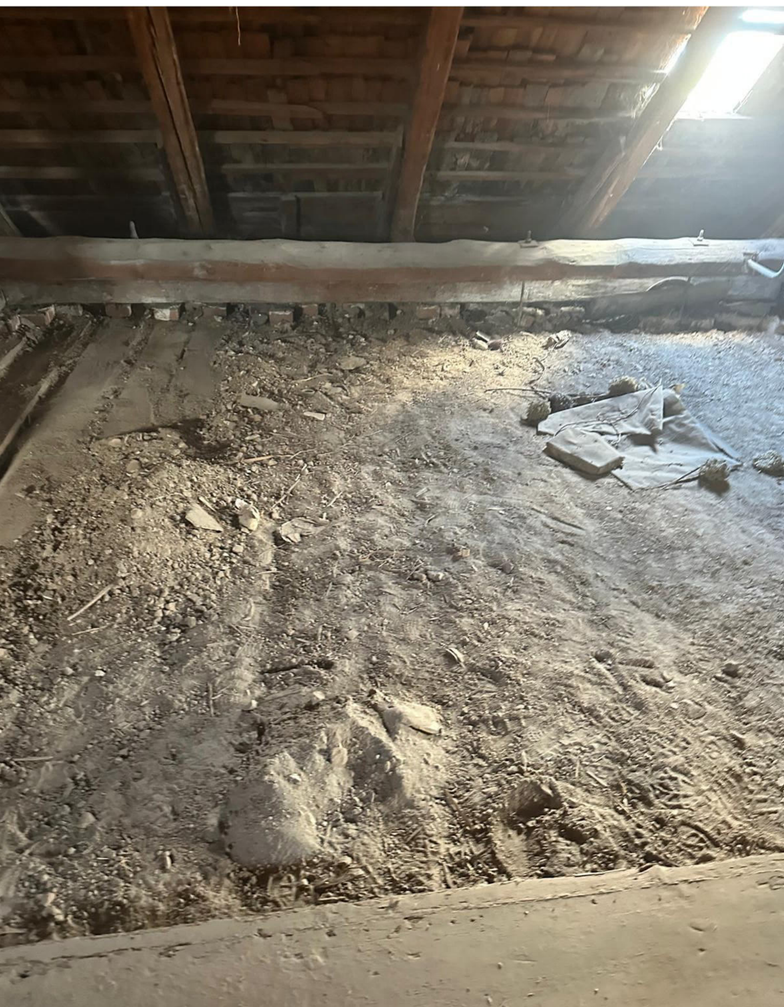
SO 01 - Násyp podlah s betonovou mazaninou
