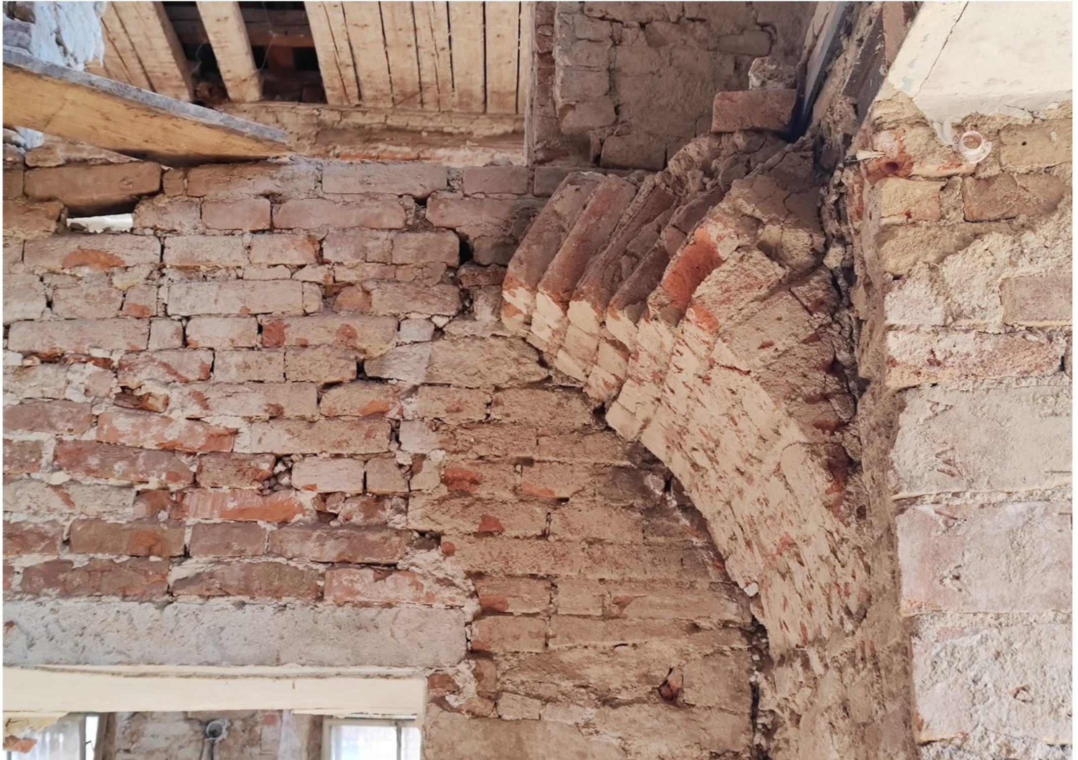
SO 01 - Demolice klenby
