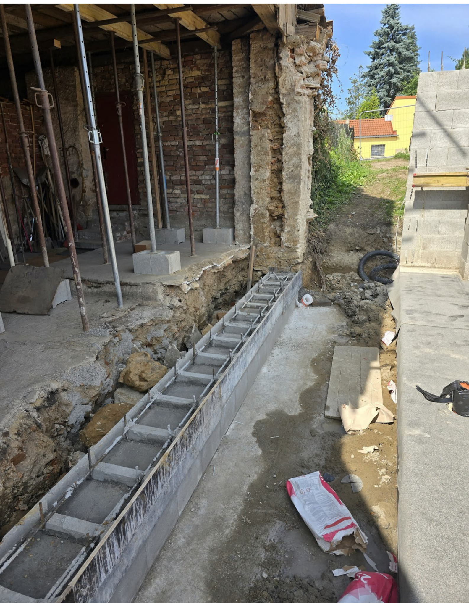
Sousední objekt - Statické zajištění, demolice, nový základ
