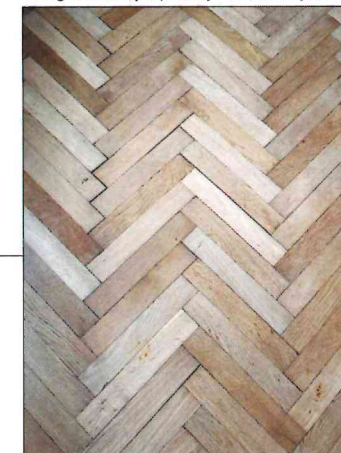
Fotografie stávající podlahy - dřevěné výsýové 1.NP
