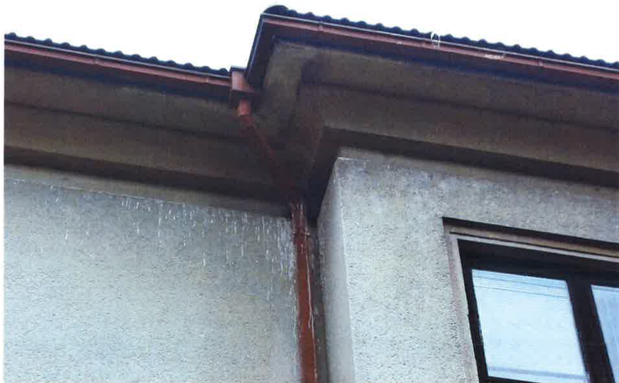
Foto 1: Jediné nalezené hnízdo na budově gymnázia patřící strace obecné ( Pica pica ).
