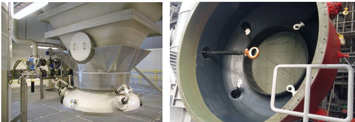
Vnější a vnitřní pohled na oblast quenche
