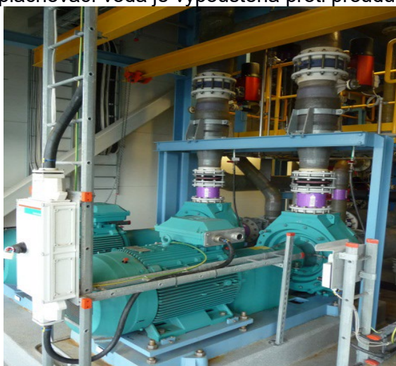
Čerpadla pro sprchovací sekci (quench)
