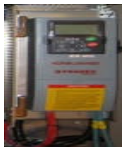
Obrázek 4. D2R se skládá z LCL-filtru, pohonné jednotky (PSU) a řídicí jednotky (CSU), z nichž každá je sestavena ve vlastní skříni.
