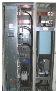
Obrázek 4. D2R se skládá z LCL-filtru, pohonné jednotky (PSU) a řídicí jednotky (CSU), z nichž každá je sestavena ve vlastní skříni.
