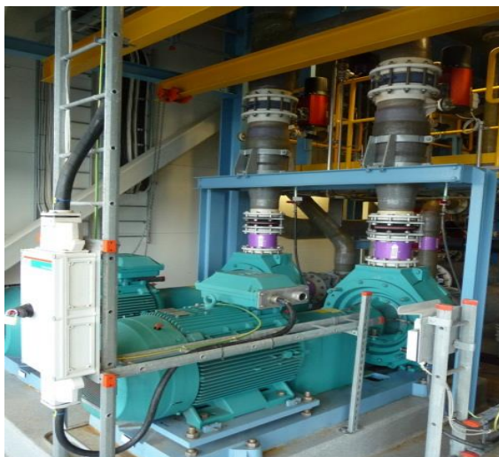
Čerpadla pro sprchovací sekci (quench)
