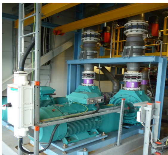
Čerpadla pro sprchovací sekci (quench)
