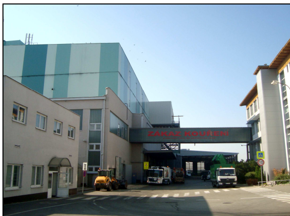
Foto 1: Terén mezi vstupní budovou SAKO a kotelnou vlevo na vyšší výškové úrovni.
