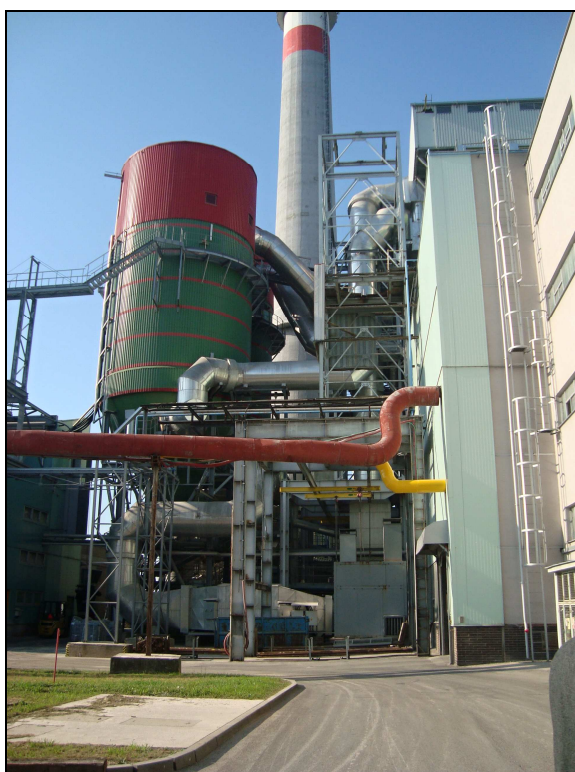
Foto 3: Objekt pro instalaci nového kotle vpravo (zelená budova).
