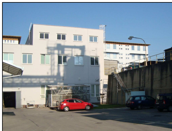
Foto 2: Několikametrový terénní stupeň mezi výškovou úrovní vstupní budovy a podlahami kotelny je zajištěn opěrnou zdí vpravo.
