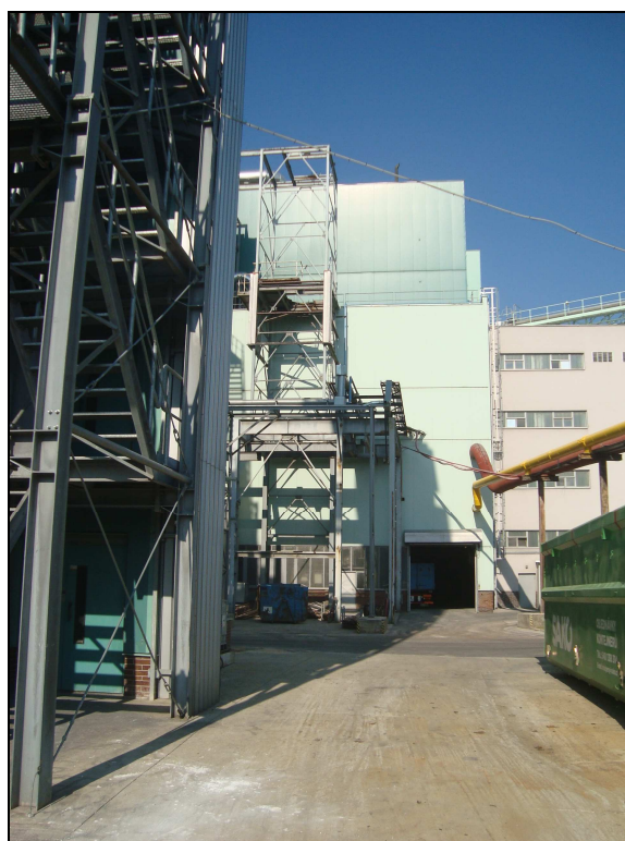
Foto 4: Možný příjezd vrtné techniky do haly nového kotle (běžný vjezd pro nákladní automobily).
