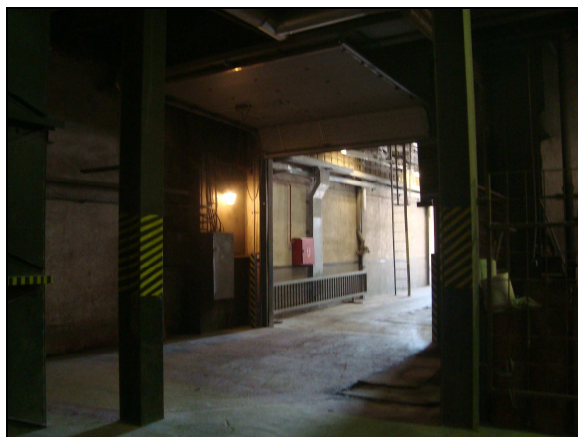
Foto 6: Stísnění podmínky pro příjezd do haly nového kotle mezi ocelovými nosníky.
