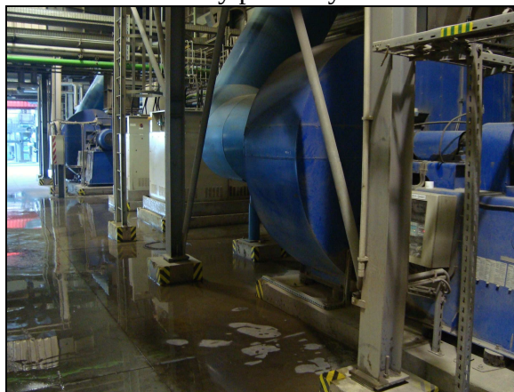
Foto 8: Založení konstrukcí sousedních kotlů na pilotách a betonových patkách.
