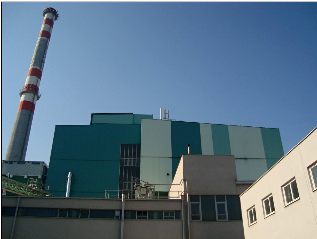
Objekt kotelny pro umístění nového kotle.
