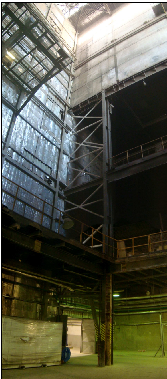
Foto 5: Hala pro výstavbu (instalaci) nového kotle.
