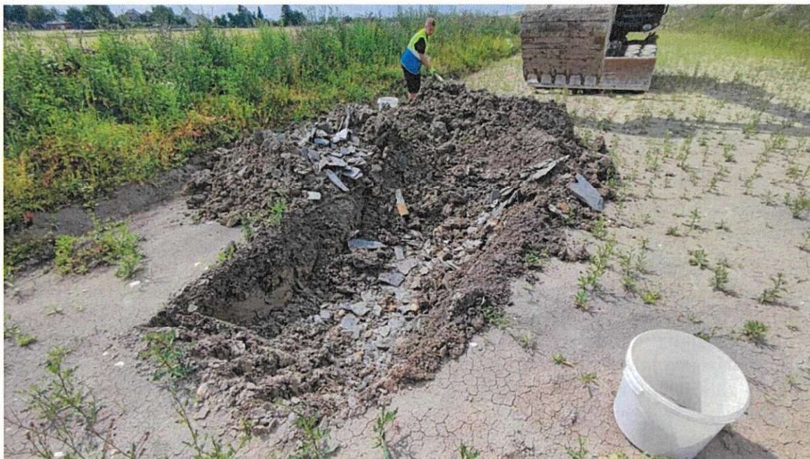
Obr. 1 Snímek skladby podloží hlavní trasy po provedených skrývkách v km 1,400.
