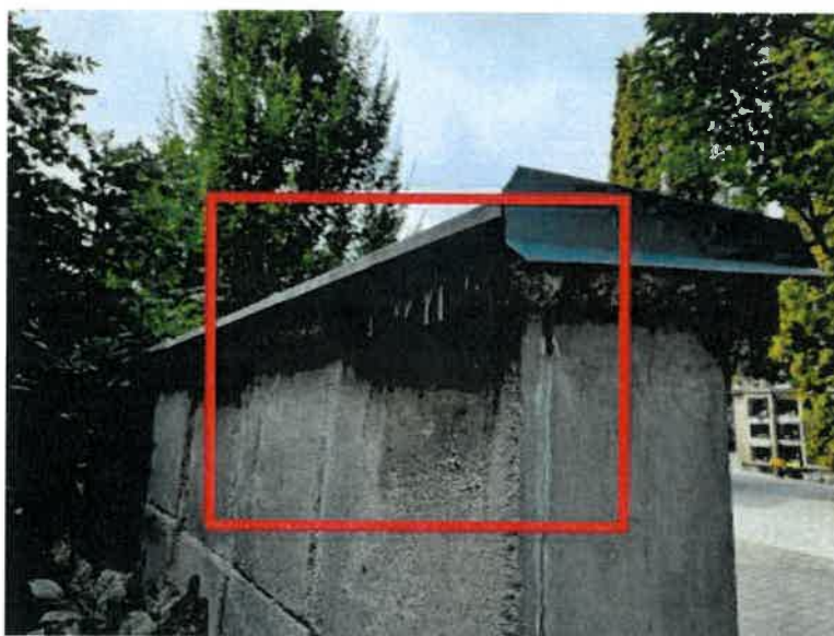
Obrázek 7 - dožilá hydroizolace
