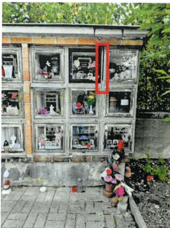
Obrázek 10 - odtržené schránky v blocích
