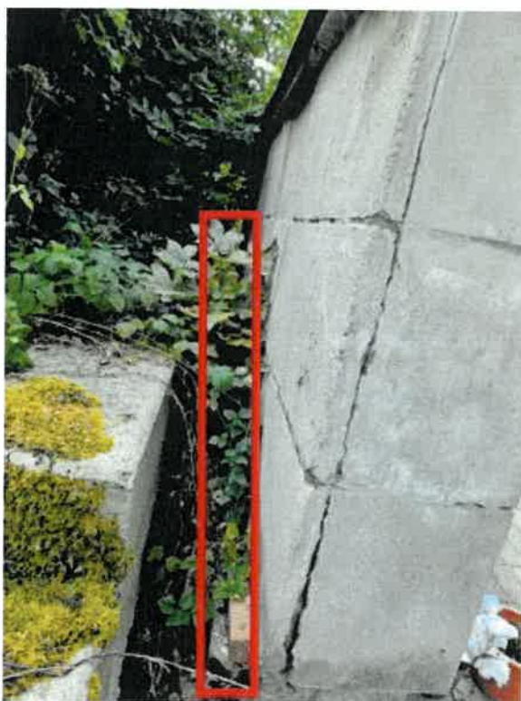
Obrázek 9 - nefunkční odvodnění
