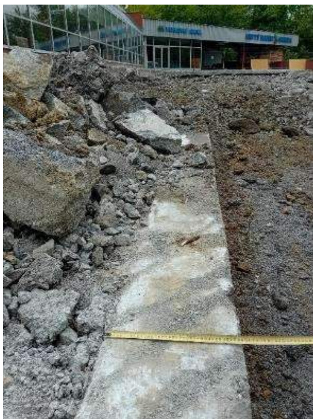
Skryté základy č.1-3
