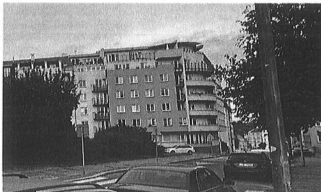
Objekt na nároží Kašparovo nám. a ul. Krejčího (č.p. 2271 k.ú. Libeň) – podlažnost 5+2 NP
