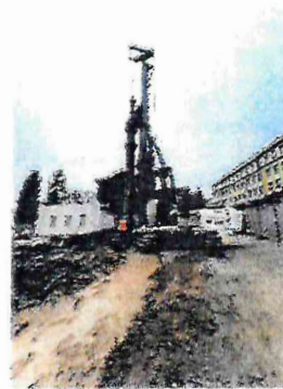
Vrtání zápor stěny
