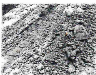
Nezhutnitelný materiál na zpětný zásyp
