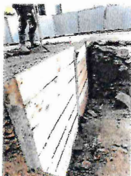
Výdřeva + zabetonování hlavy zápor
