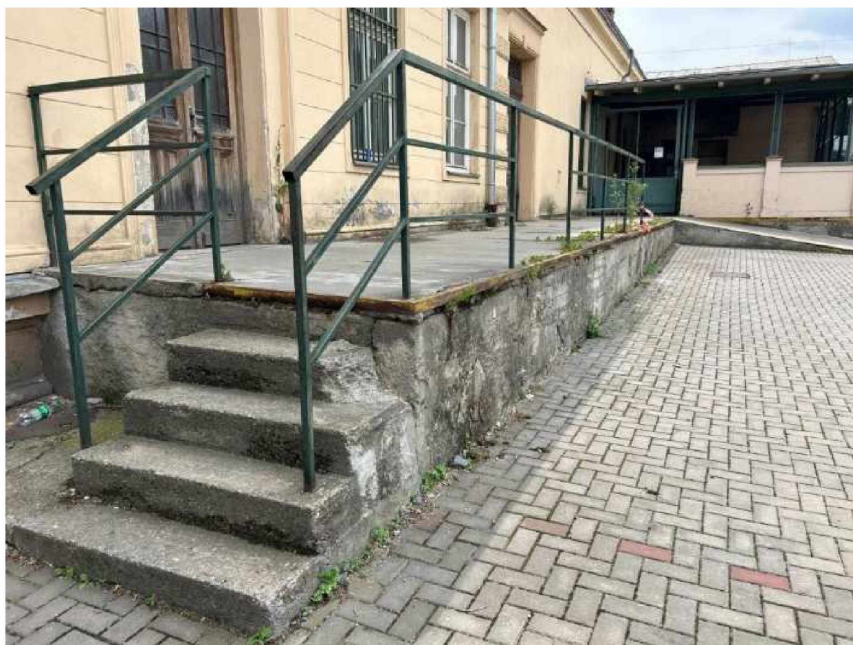
Vyspravení boční rampy
