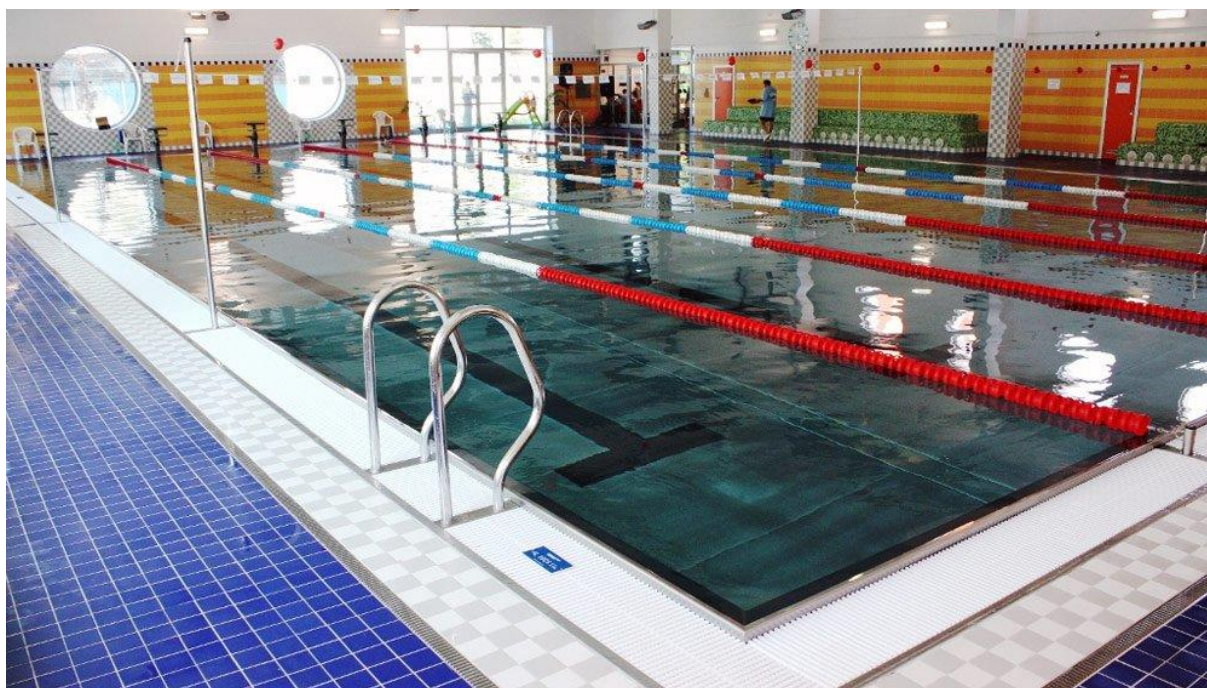
Obrázek 1 – Krytý plavecký bazén Zábřeh
