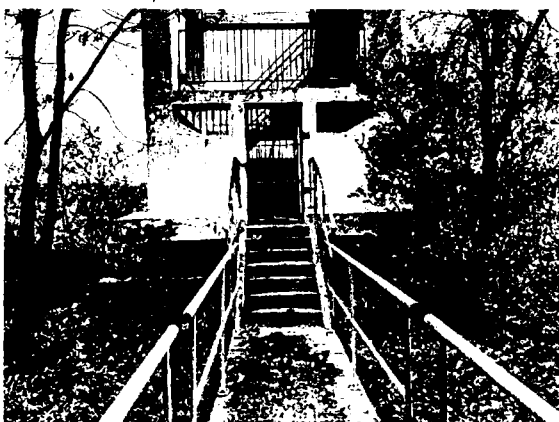
Obr. 7 – Vstup na rozhlednu přes vodojem
