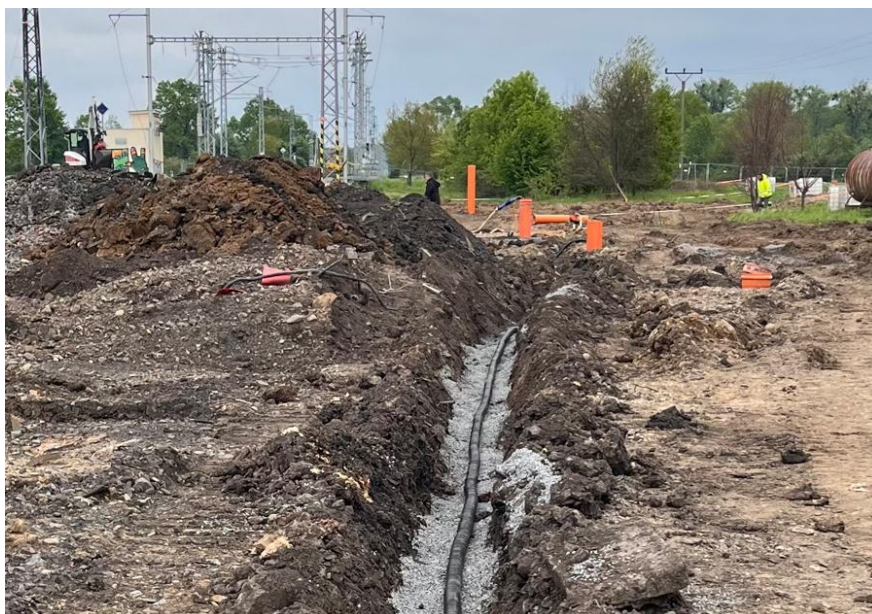
Obr. 7 Instalace ventovacího drénu do výkopu
