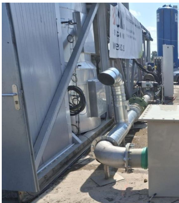
Obr. 16 Mobilní katalytická oxidační jednotka RP-6.0 na lokalitě v Hustopečích
