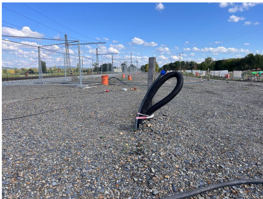
Obr. 8 Současný stav prostoru s ventovacími drény
