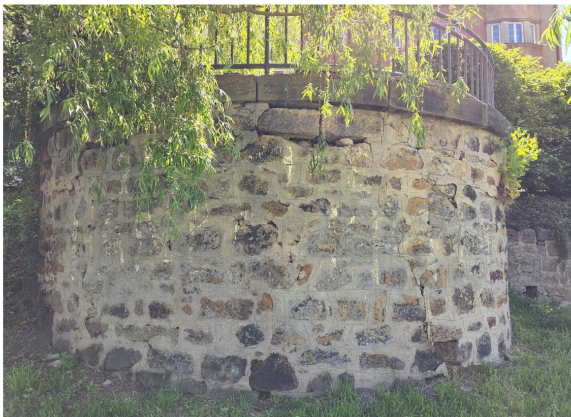
Obrázek 2: Čelní pohled na opěrnou zed'
