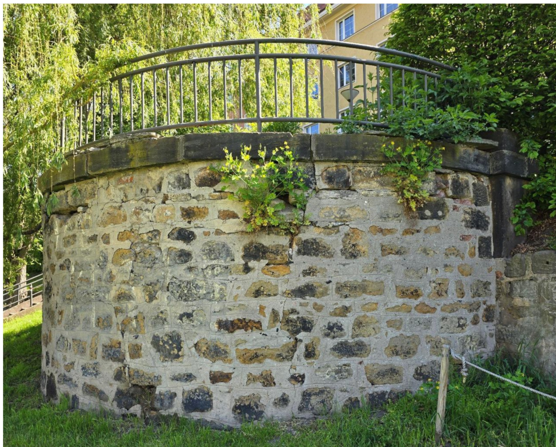
Obrázek 1: Pohled zprava na opěrnou zed'
