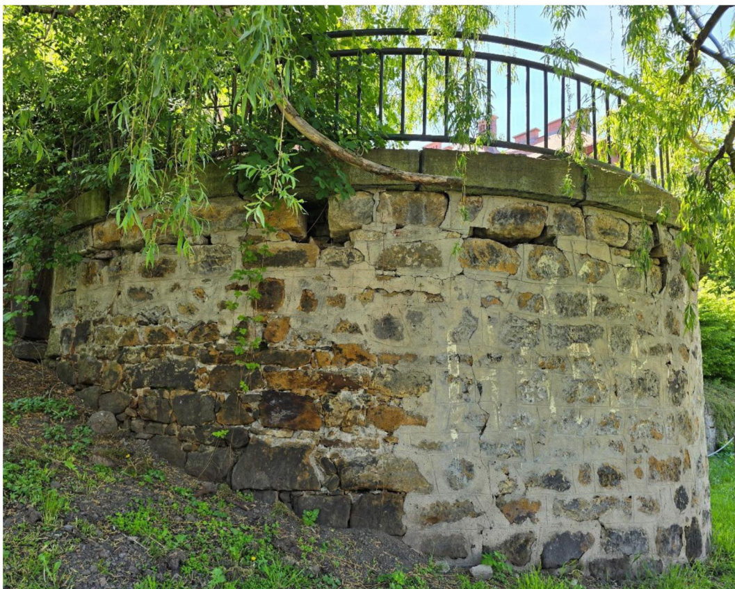
Obrázek 3: Pohled zleva na opěrnou zeď
