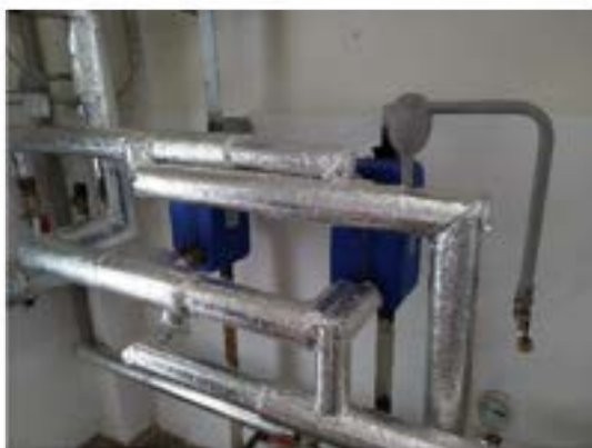
deskové výměníky tepla
