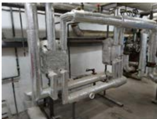
deskové výměníky tepla
