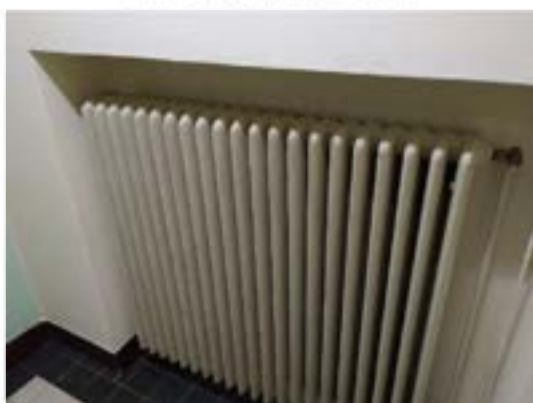
litinové otopné těleso bez TRV
