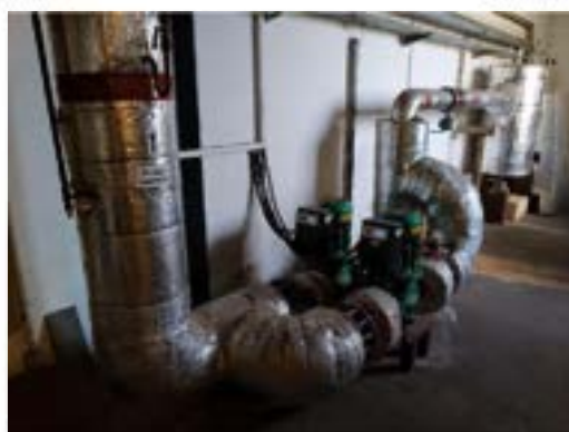
oběhová čerpadla horkovodu
