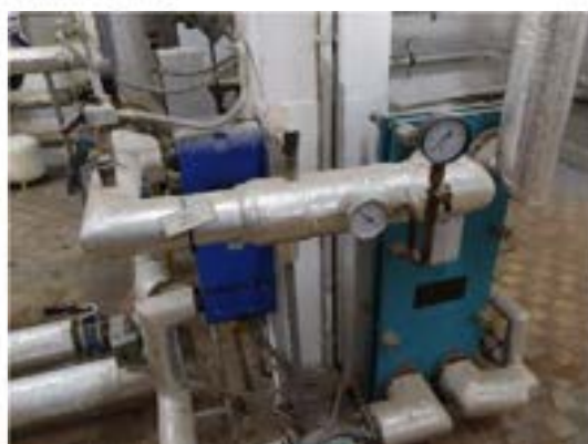
deskový výměník pro TV (horkovod/teplá voda)
