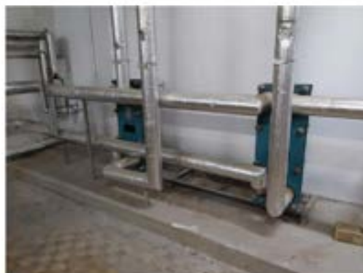
deskové výměníky pro ÚT
