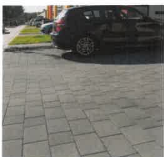
maloformátová betonová dlažba
