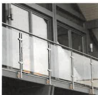
skleněné výplně zábradlí
