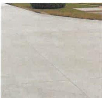
velkoformátová betonová dlažba
