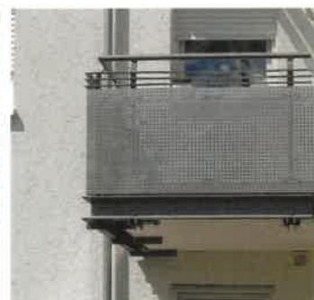
prostorově komplikované zábradlí
