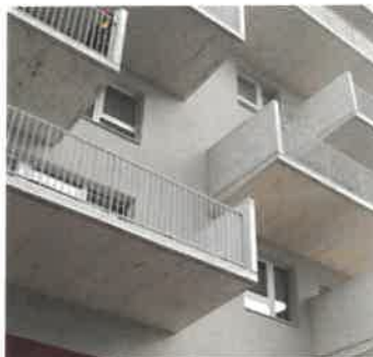
přiznaná nosná betonová konstrukce
