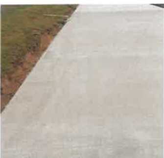
betonové monolitické plochy
