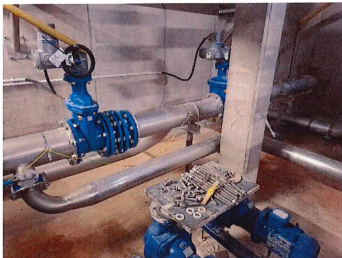
Namontované provizorní potrubní propoje ve strojovně SO0004.
