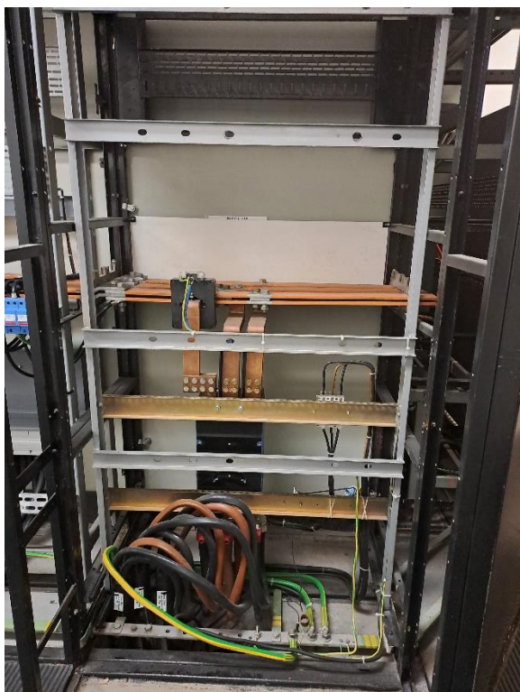
Obr. 5 – Rozváděč NN – pole r.3
