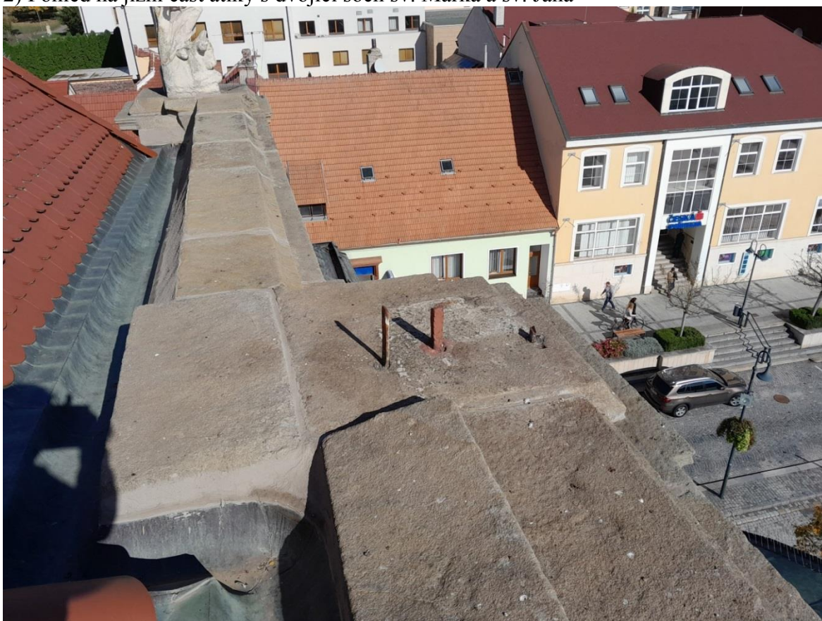
3) Pohled na část pískovcové atiky s místem pro osazení sochy sv. Matouše
