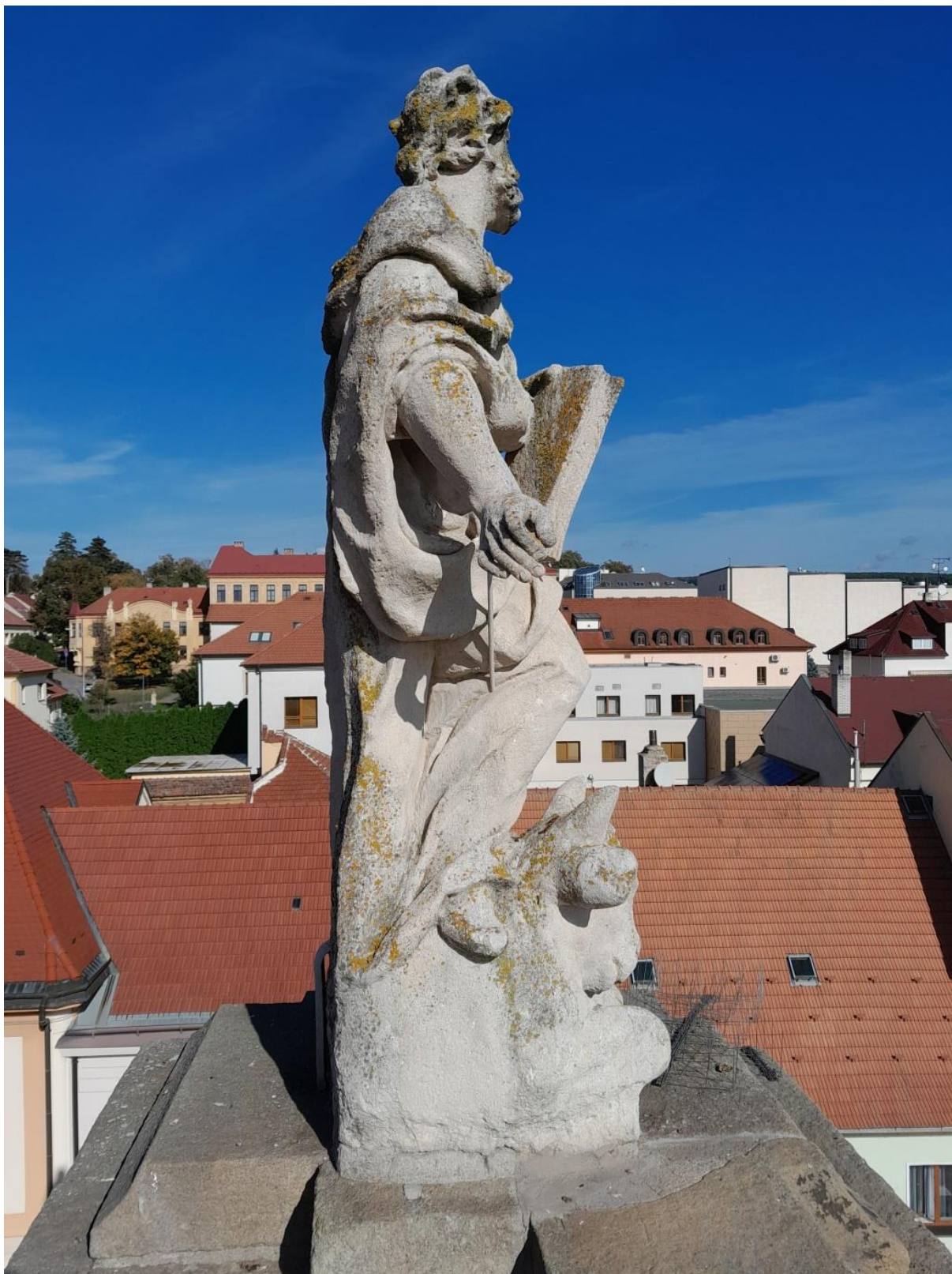
1) Nárožní socha sv. Lukáše. Od restaurování v roce 2013 je povrch pokryt lišejníky. Nutná obnova vápenného ochranného nátěru.
