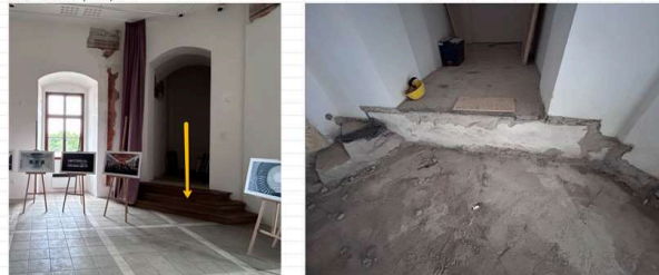
Pol.4 Bourání schodišťových stupňů
