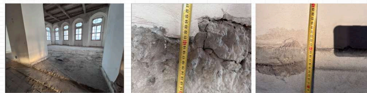
Pol.6 Bourání mazonin betonových
