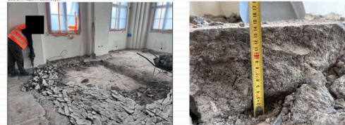
Pol.6 Bourání mazonin betonových
