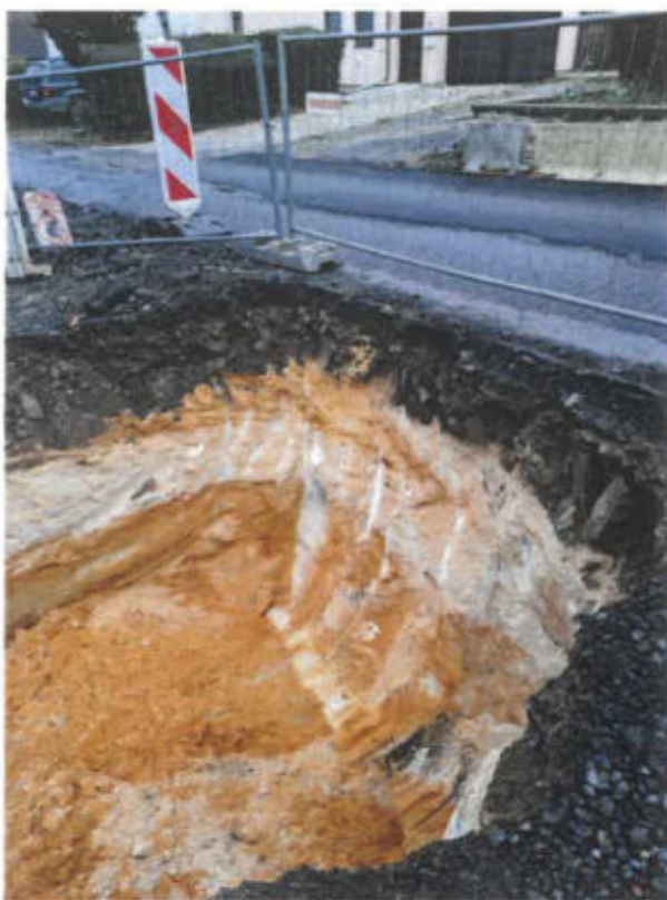
Obr. 1 Kopaná sonda KS1 (hl. 1,3 m)
