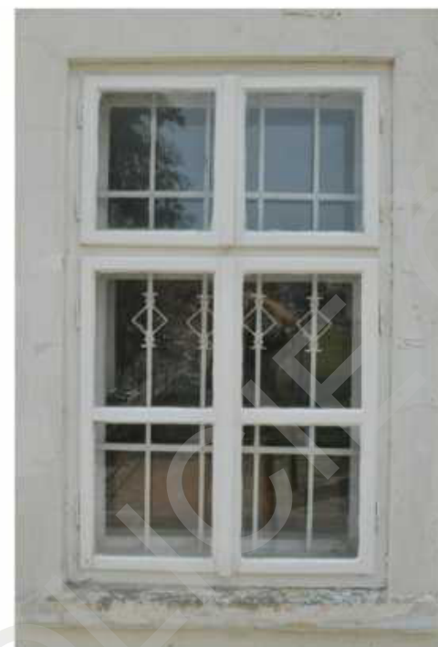
příklad obdobné klasicistní mříže a detail její skladby
