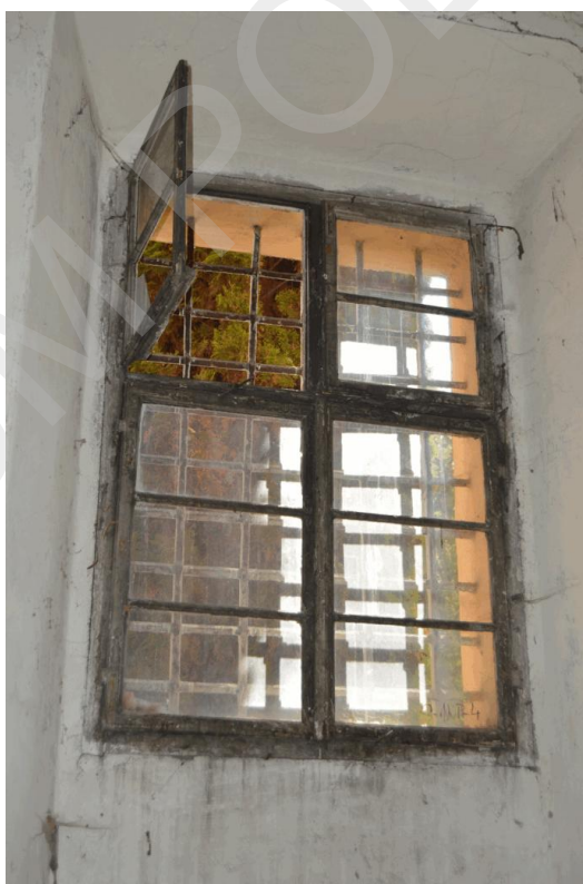
5 zachovaná historická okna S-1.NP-21 a S-1.NP-4
