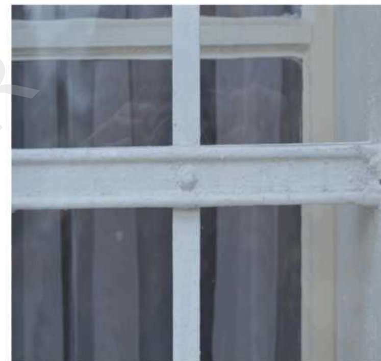
příklad obdobné klasicistní mříže a detail její skladby
