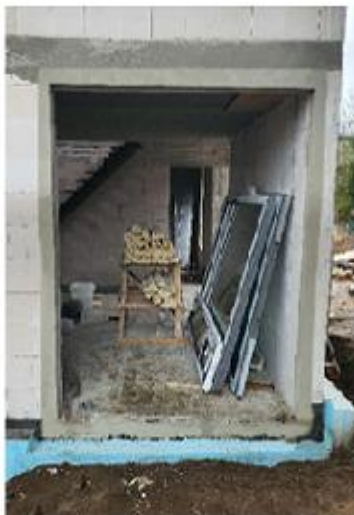
Obrázek č.2 Stavební otvor připravený pro osazení okna do vnějšího líce zdiva a předsazenou montáž
