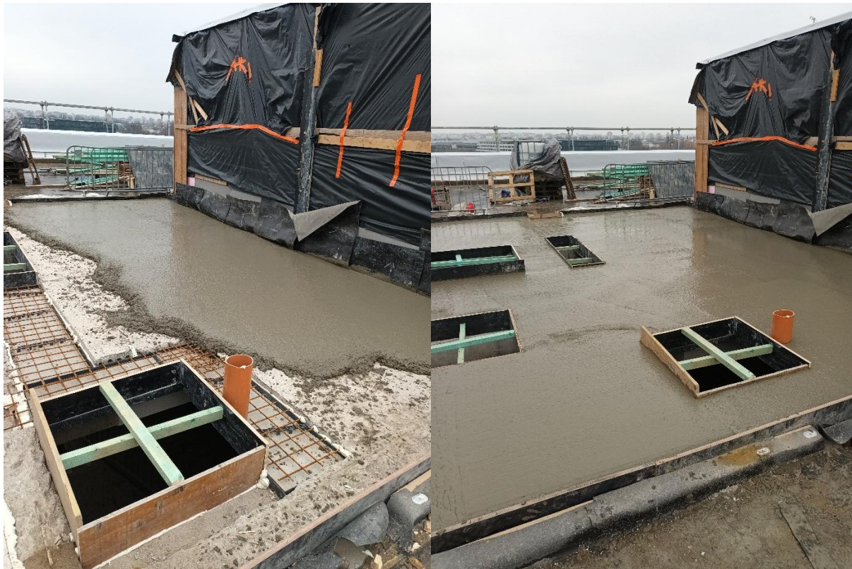
Dobetonávky na střeše kvůli změně pozice klapky SOZ a kvůli ztužujícímu jádru
