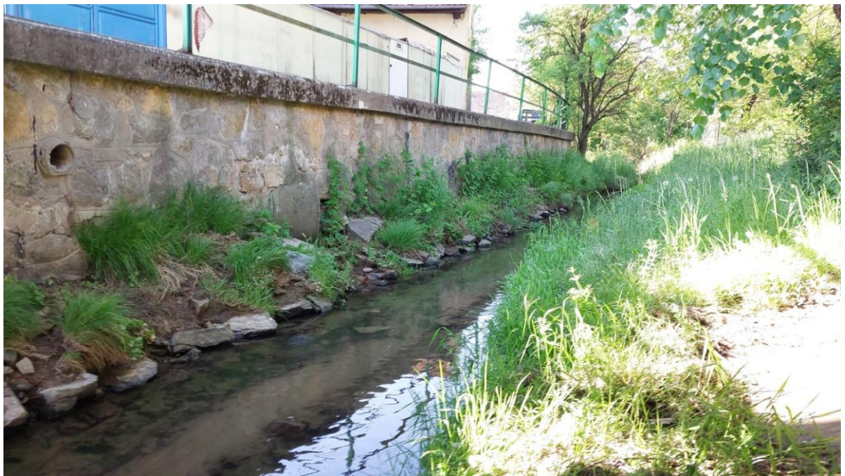
Obr. č. 1: Dolní část úseku, pohled po proudu, na LB opěrná zeď. V této části úseku bude max. odstraněn sediment z konkávního svahu či bude ponecháno bez čištění.
