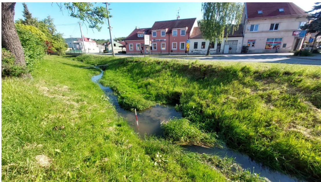
Obr. č. 3: Pohled proti proudu v ř. km 18,37 – samovolně vytvořená kyneta, kolem které jsou „pupky“ sedimentu
