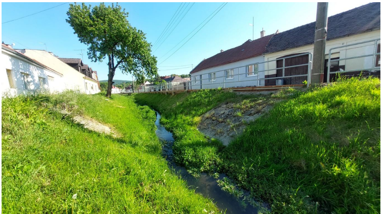
Obr. č. 2: Pohled proti proudu v ř. km 18,26 – malý nános sedimentu ve dně a na PB, svah LB bez sedimentu v těsné blízkosti komunikace. V místě křížení s IS pevné dno z dlažby.
