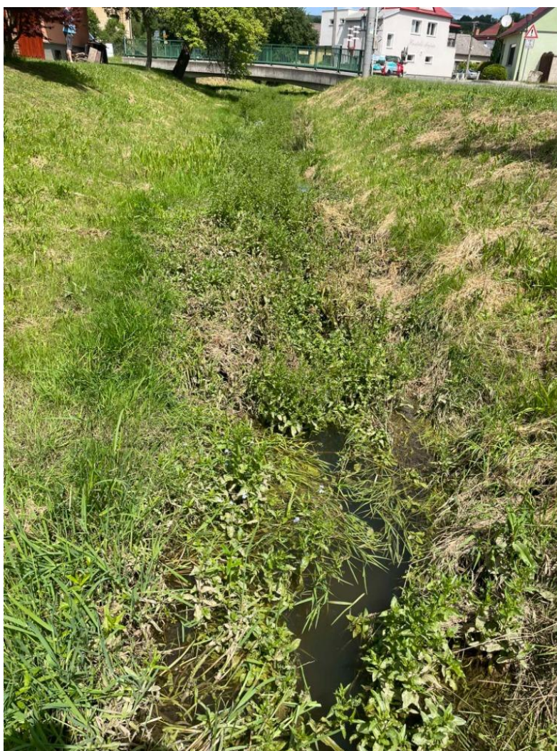
Obr. č. 4: Pohled proti proudu v ř. km 18,38 – výraznější nános sedimentu na obou stranách kynety, v samotné kynetě nános minimální – 10-20 cm.
