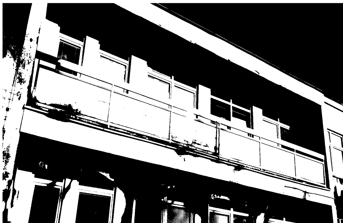
Pohled z jihu na fasádu dvoupodl. objektu s lodžii
