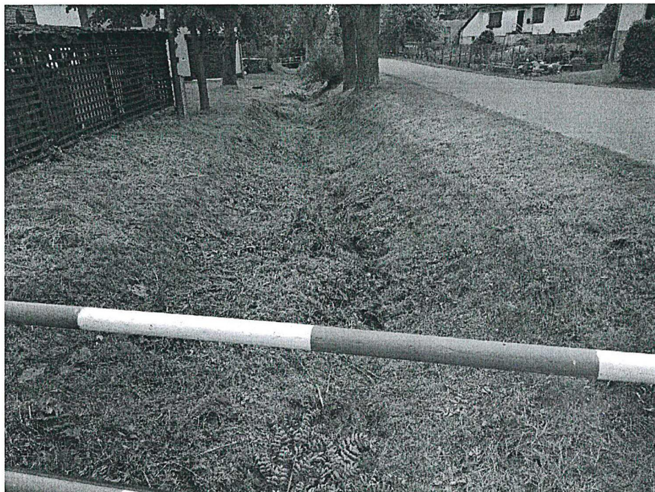
Úsek ř.km 5,55; sedimenty v korytě toku
