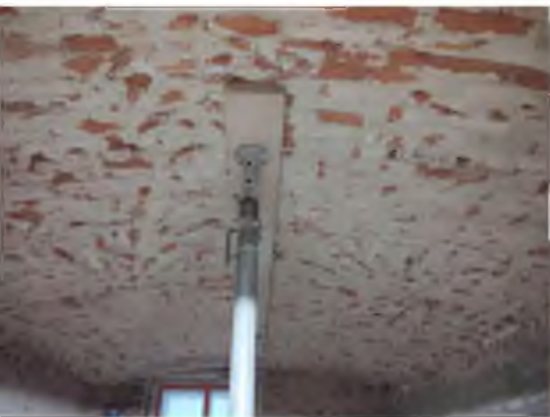
AS10_Pohled na celou klenbu.jpg
