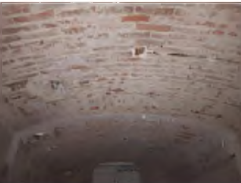
AS09_Pohled na celou klenbu.jpg
