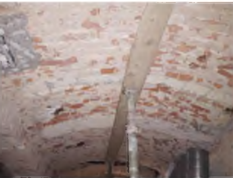
AS11_Pohled na celou klenbu.jpg
