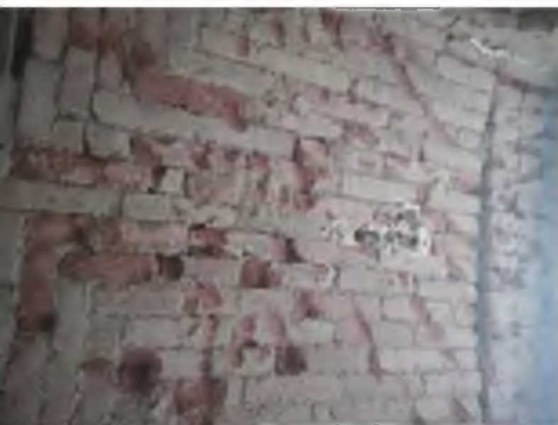
AS14_Pohled na stav cihel2.jpg
