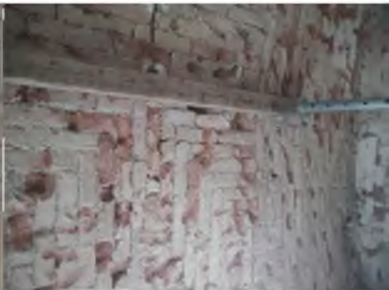
AS14_Pohled na stav cihel1.jpg
