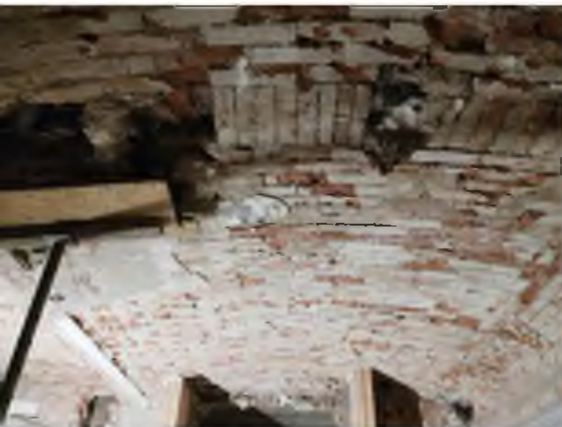
AS18_Pohled na celou klenbu.jpg
