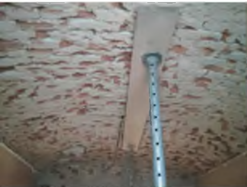
AS13_Pohled na celou klenbu.jpg
