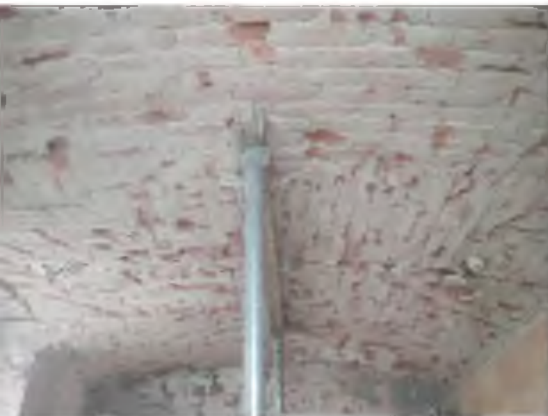
AS14_Pohled na celou klenbu.jpg
