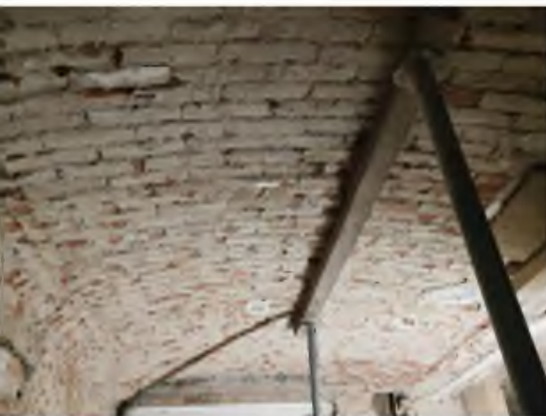
AS17_Pohled na celou klenbu.jpg
