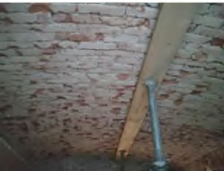
AS12_Pohled na celou klenbu.jpg
