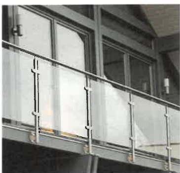
skleněné výplně zábradlí
