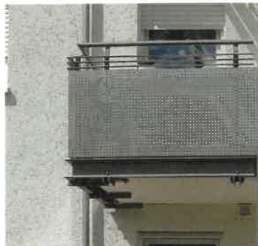
prostorově komplikované zábradlí
