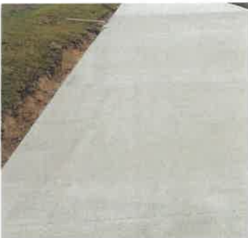
betonové monolitické plochy
