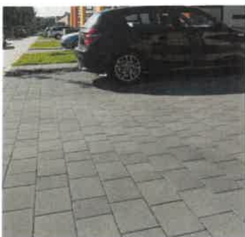
maloformátová betonová dlažba
