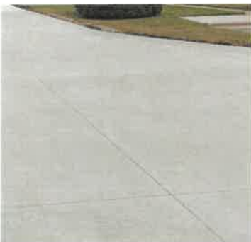
velkoformátová betonová dlažba
