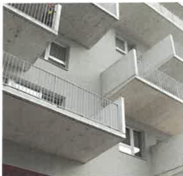
přiznaná nosná betonová konstrukce
