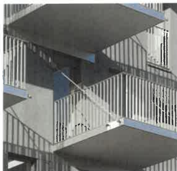
přiznaná nosná kovová konstrukce
