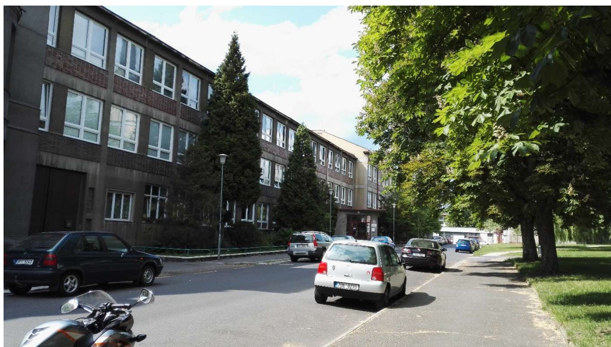
Obrázek 4 Přístavba – objekt ze 60. let (1)
