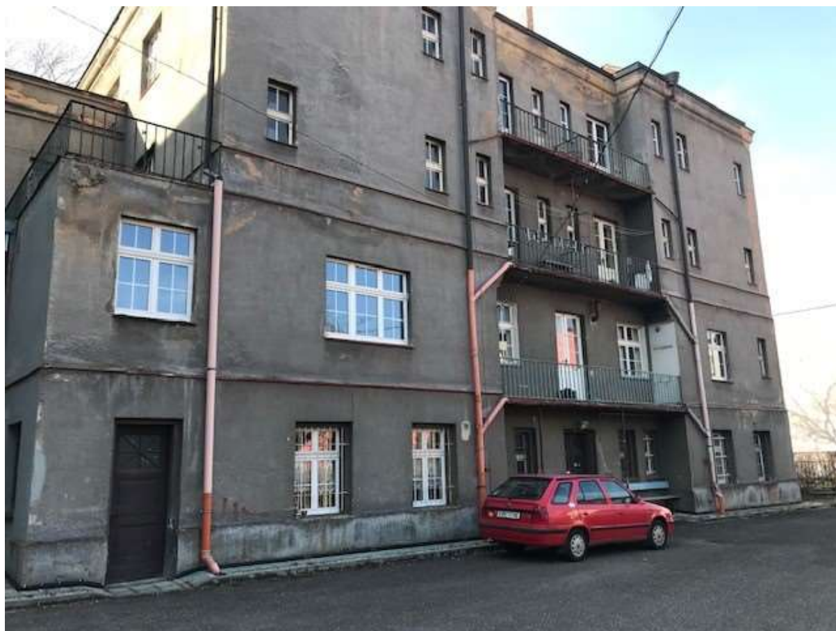
Obrázek 3 Bytový dům – objekt určený k demolici
