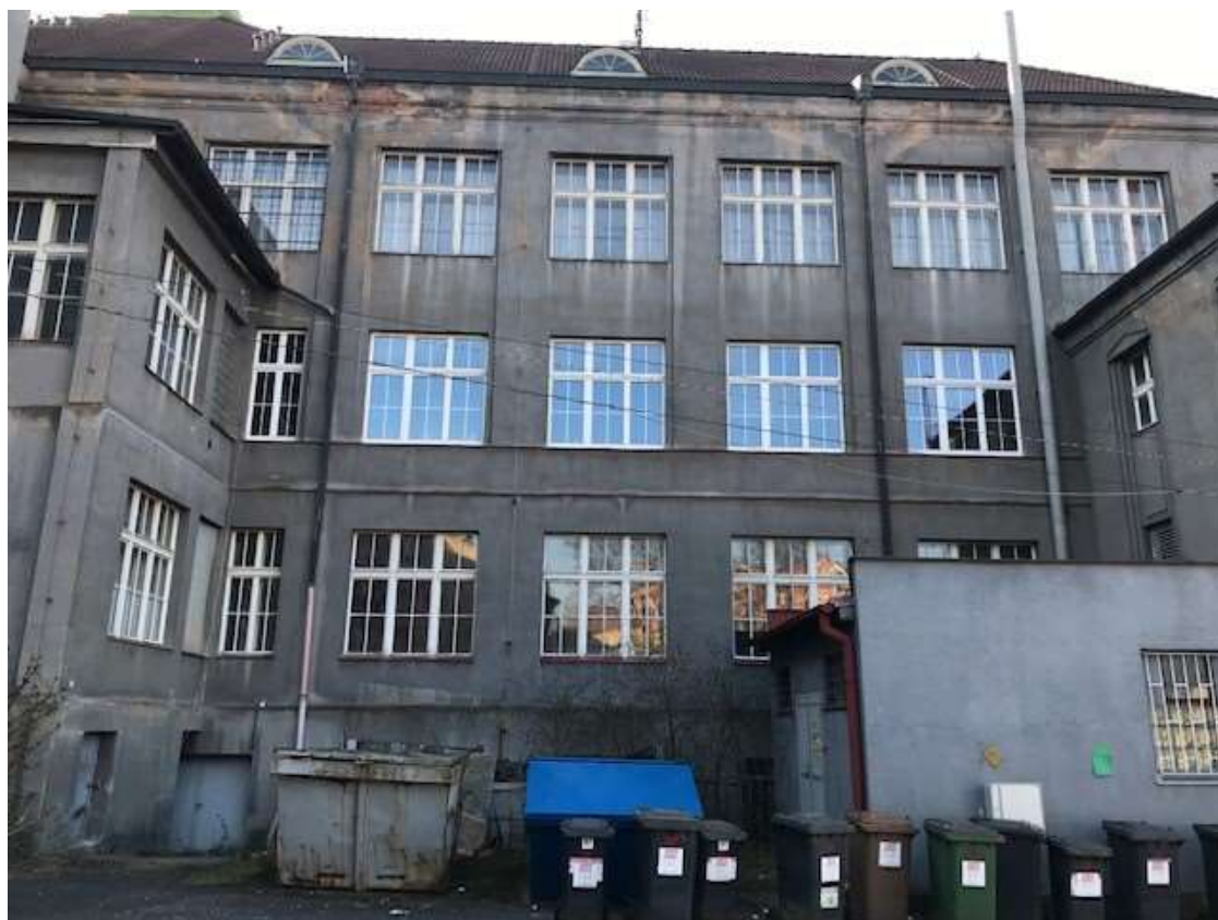
Obrázek 5 Přístavba – objekt ze 60. let (2)
