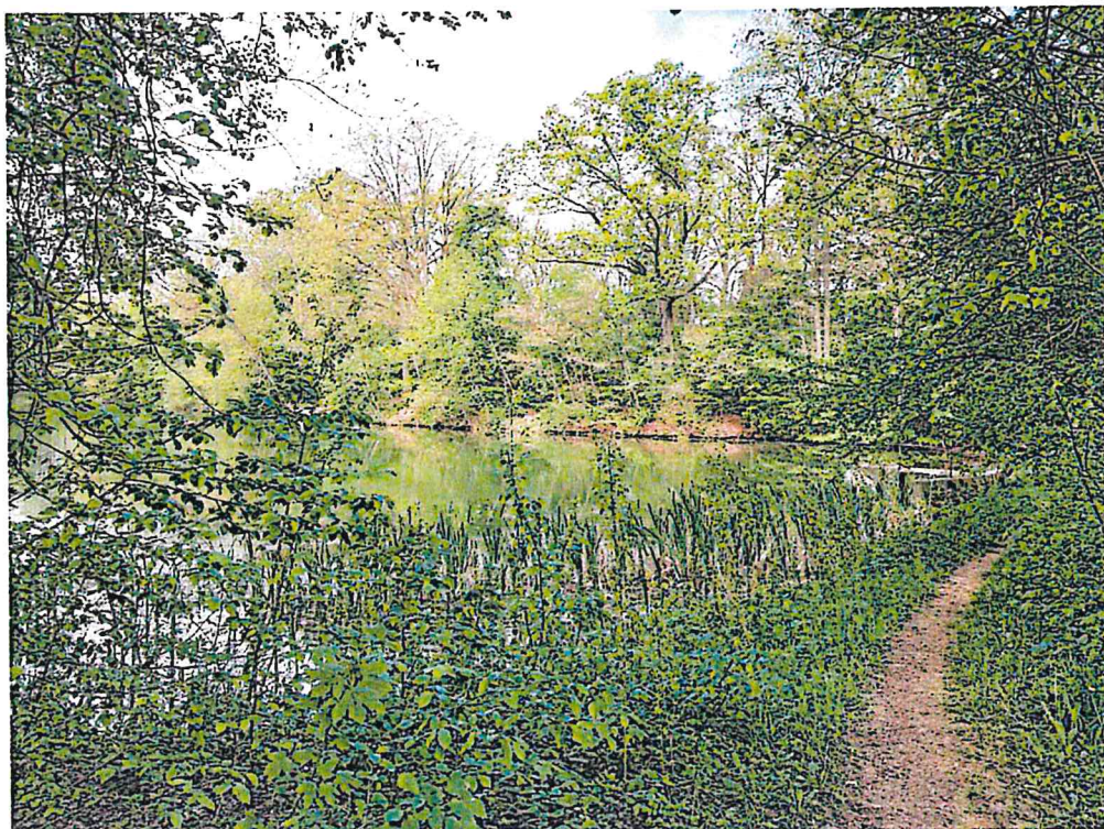
Foto č.7: Příchod od LB – pohled na zátopu, korunu hráze se sdruženým výpustným objektem.
