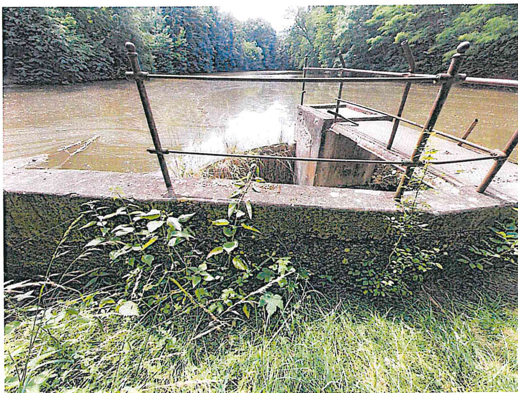
Foto č.3: Pohled na půlkruhový sdružený výpustní objekt a zátopu VN Kníničky
