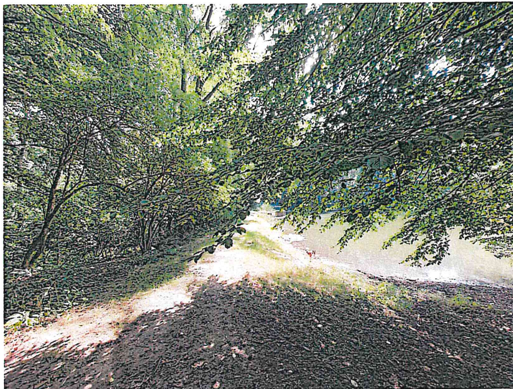
Foto č.3: Pohled z PB na pochozí korunu hráze VN Kníničky včetně patrné vegetace na vzdušném líci
