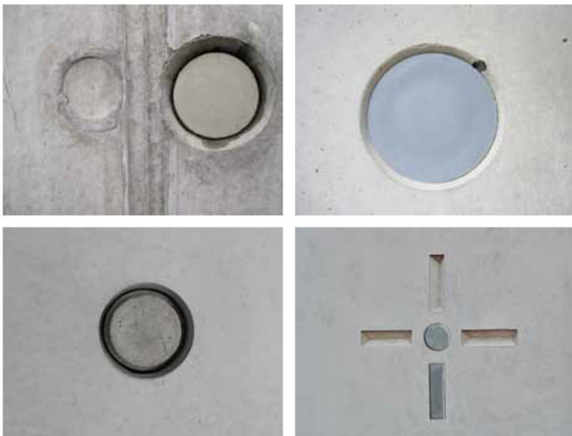
(23) Obr. F.2 – Různé způsoby uzavření spínacích otvorů
