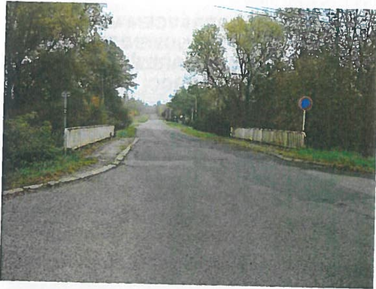
Pohled proti směru staničení
