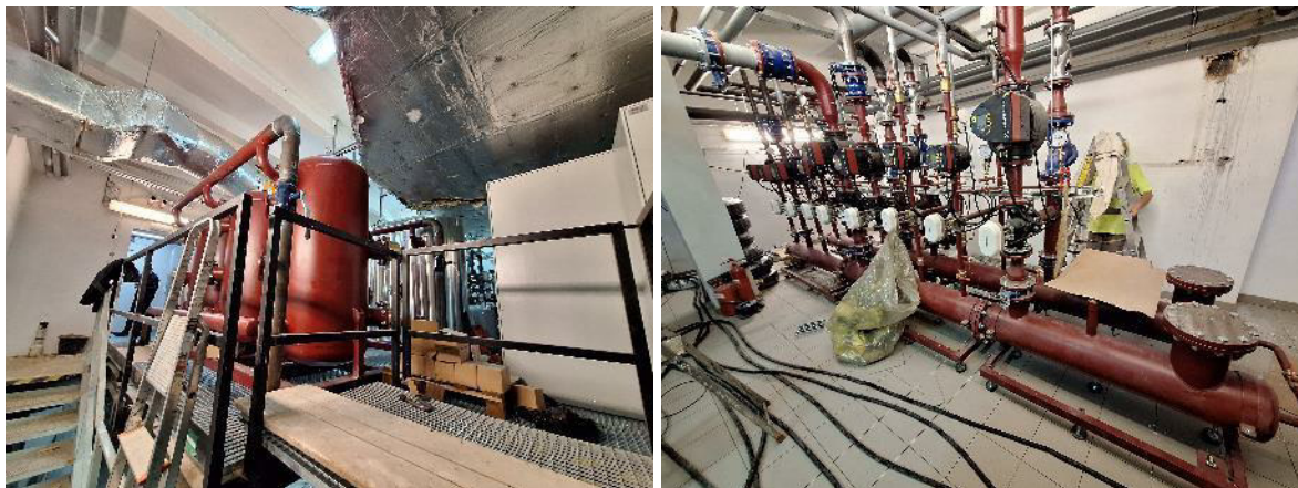
Elektrokotelna během rekonstrukce
