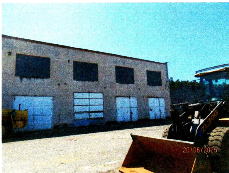
Foto č.3 Třetí vrata zprava jsou již vyměněná, jsou vyšší.
