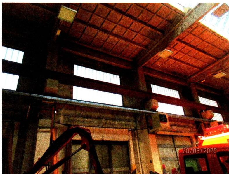
Foto č.2 Nosnou konstrukci haly tvoří železobetonový skelet , který má plášť proveden z keramických panelů.
