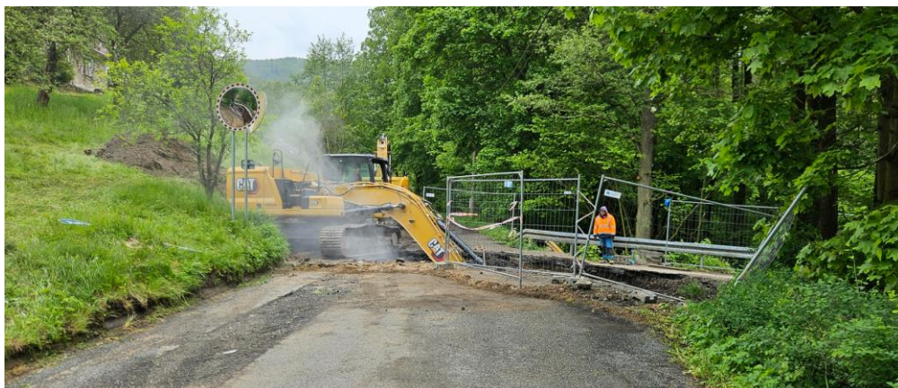
fotografie bouracího kladiva v akci - při rozpojování odolné horniny
