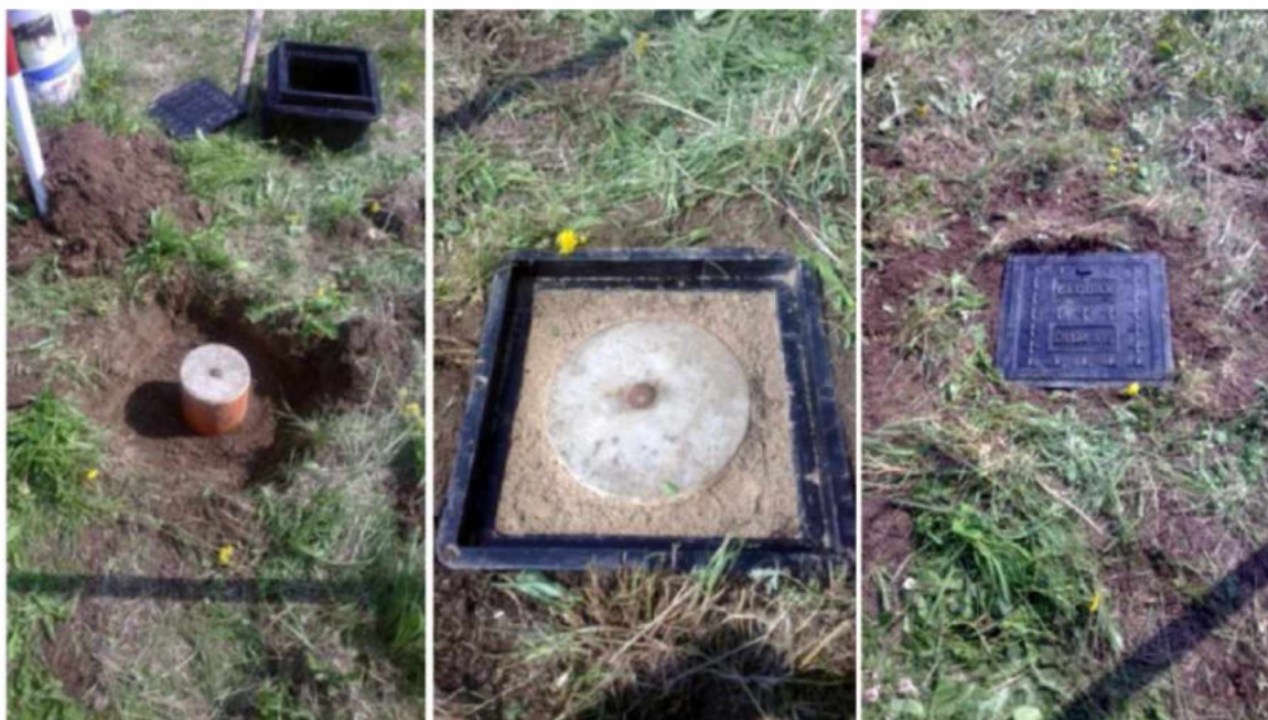
Obrázek 41 Příklad řešení plastové šachty hranaté
