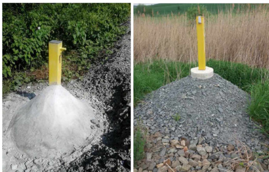
Obrázek 17 Řešení zhotovitele pro zvýšení stability zajišťovací značky
