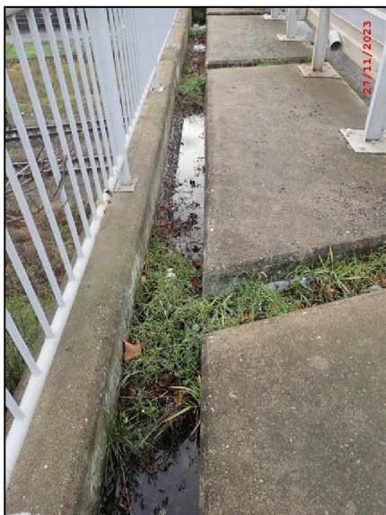
41-Odvodňovací žlab na PS - zcela zanesen neodtéká.jpg
