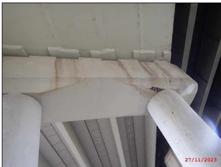
15-P2 pravý sloup separovaný beton koroze výztuže s oslavením.jpg
