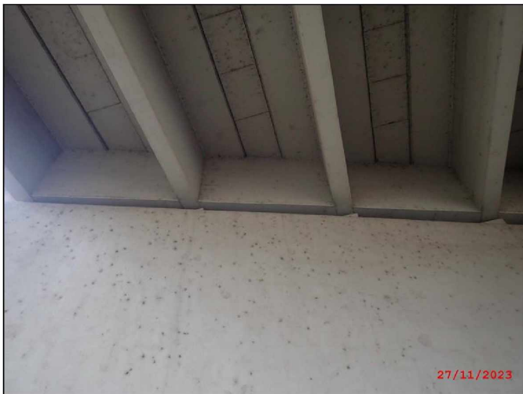
07-OP1 - pohled na příčník na opěrou.jpg
