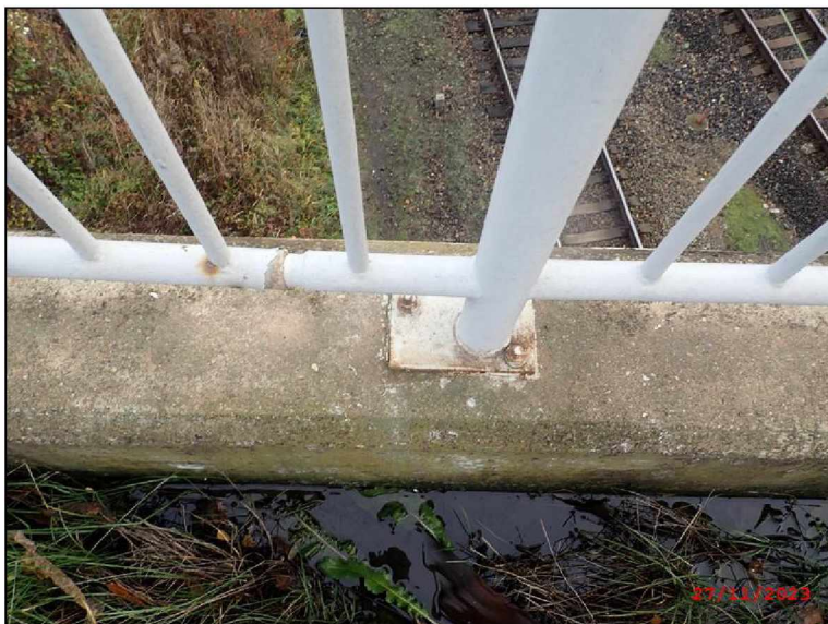
41-Odvodňovací žlab na PS - zcela zanesen neodtéká.jpg
