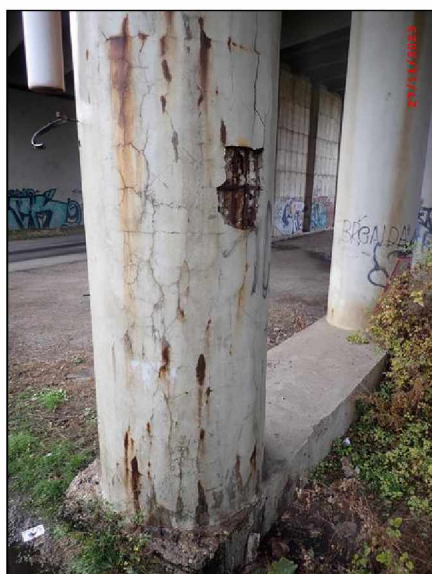
15-P2 pravý sloup separovaný beton koroze výztuže s oslavením.jpg
