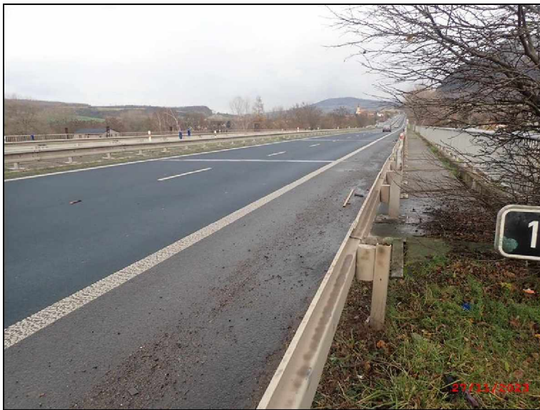
01-Pohled ve směru staničení.jpg
