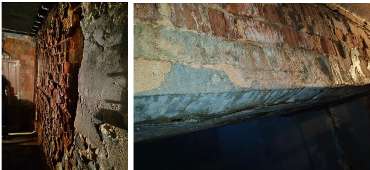
Na levé fotografii výše je část nasávacího kanálu strojovny 1C. Na pravé překlad u kanálu strojovny 1A.
