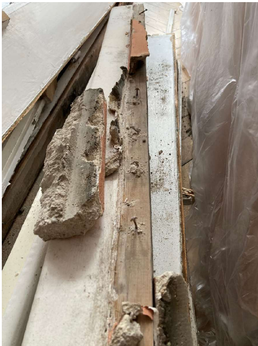
Obr. č. 2 – kotevní hřebíky na původní výplni
