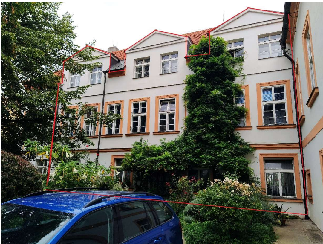
Obr. č. 3 – pohled na předmětnou fasádu s vyznačením opravované části
