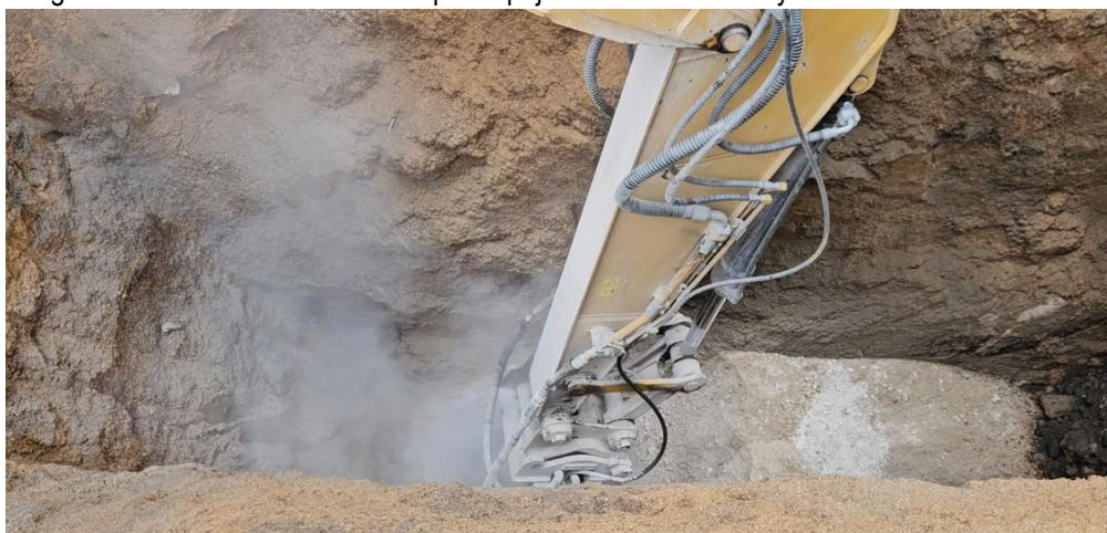
fotografie bouracího kladiva v akci - při rozpojování odolné horniny
